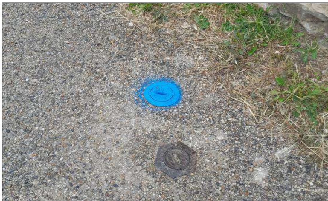
**Une fuite a été détectée, au niveau d'une vanne, sur ce tronçon au chemin des Tallabardes. Le renouvellement de la vanne est programmé, le tronçon restera à surveiller car le bruit de fuite était important dans ce secteur.**
