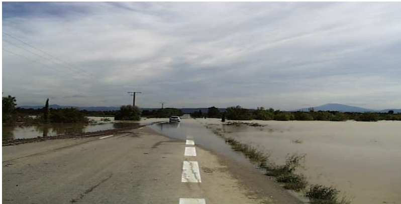
Inondation d'une route près de Rohegude
