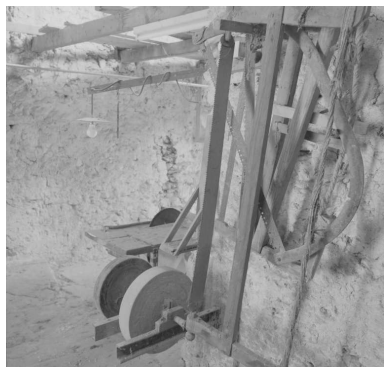
Village intra-muros, maison (AX 100), ancien atelier de menuiserie : scies et meules à aiguiser.
