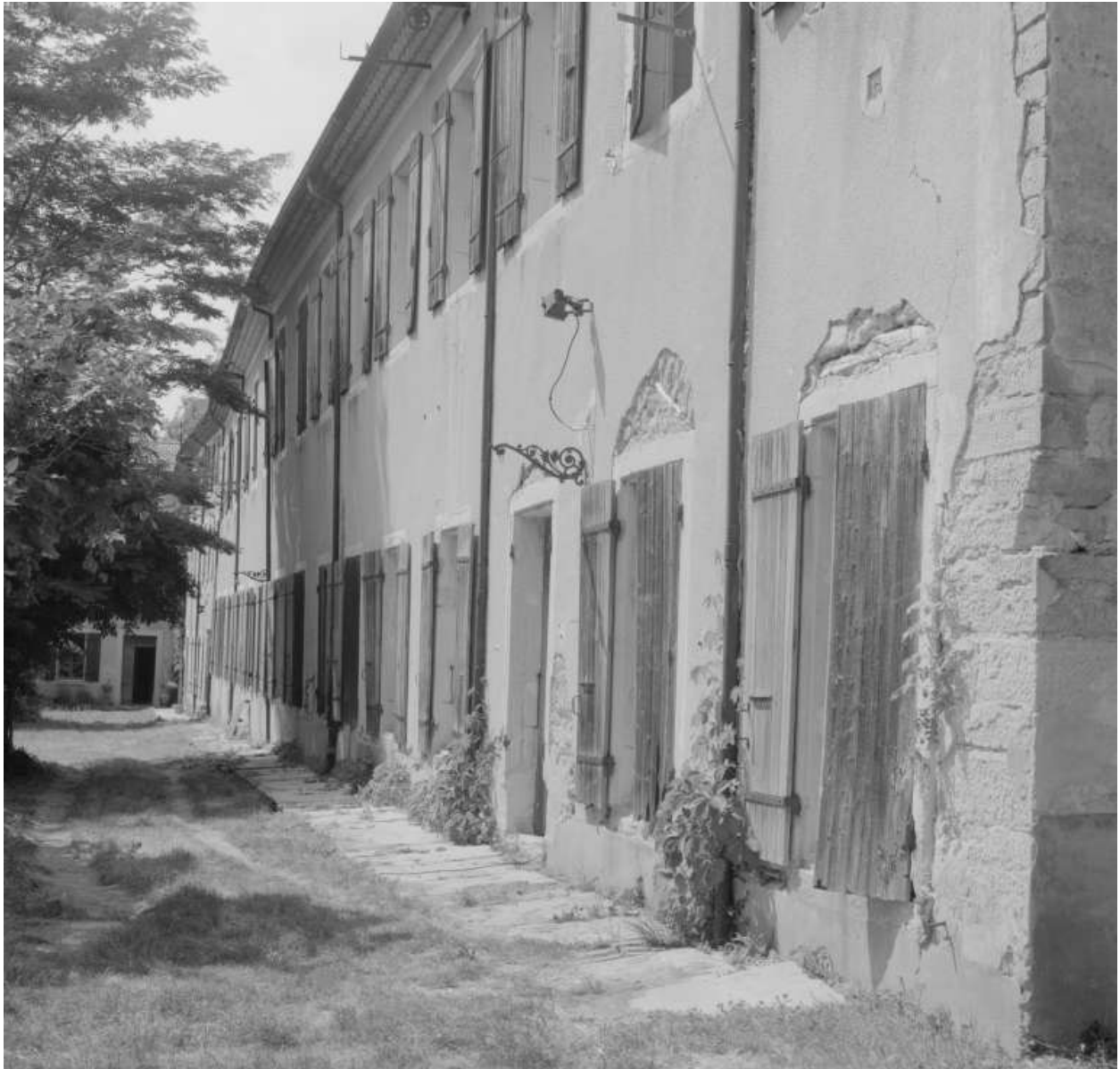
Aile nord, anciens ateliers de moulinage, façade.
