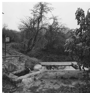
Montjoyer. Hameau de Citelles. Vue d'ensemble du lavoir à ciel ouvert. Phot. Alain Franchella IVR82_19992600581X
