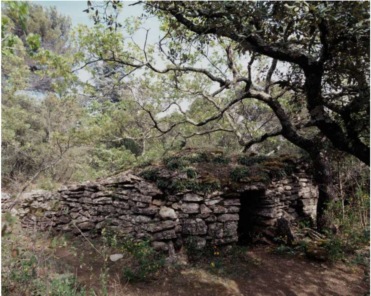
Chamaret. Les Evabres. Borie adossée à un muret.
