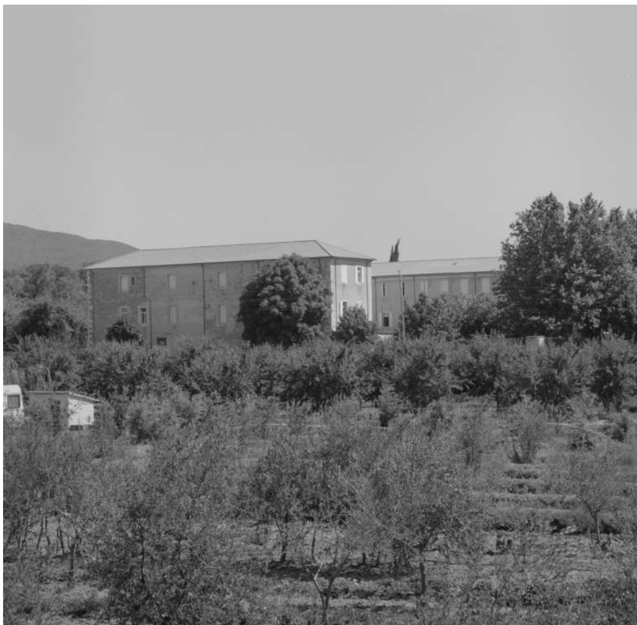
L'Ecluse. Vue d'ensemble de l'ancien moulinage dit usine de l'Ecluse, actuellement monastère de la Clarté Notre-Dame.
