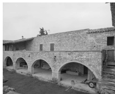
Quartier Rousselle (A3 530). Elévation sud, à galerie accessible par escalier extérieur. Phot. Alain Franchella IVR82_20002600397X
