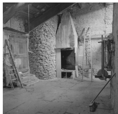
Village intra-muros, maison (AX 100), dépendance : ancien atelier de menuiserie. Phot. Eric Dessert IVR82_20002600934X
