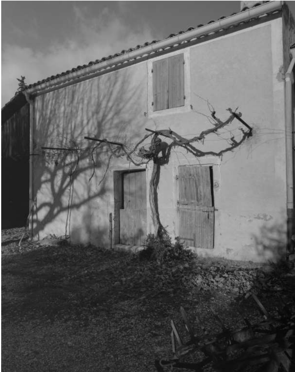
Montbrison, route de Crest (R.D. 538). Dépendance agricole ornée d'une treille.
