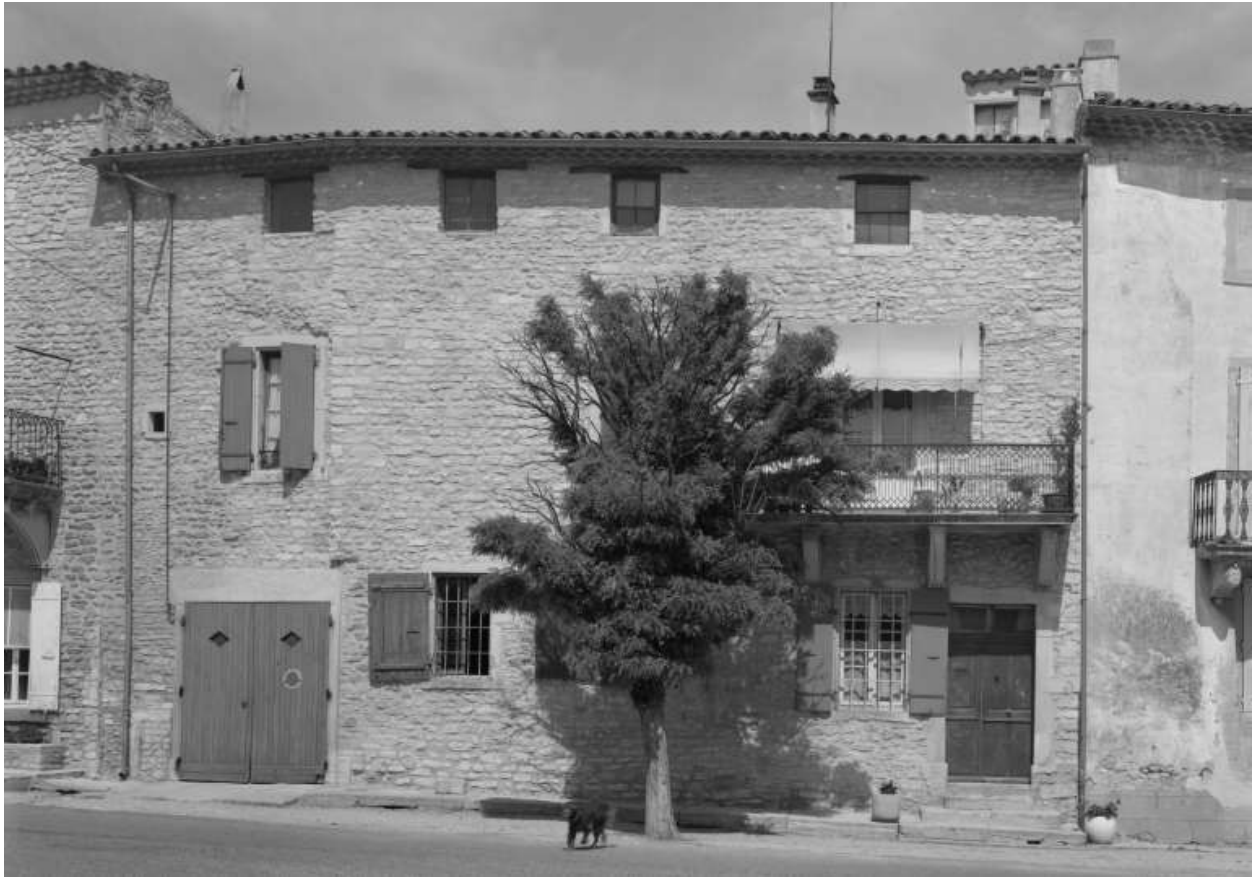
Place du 11 Novembre. Exemple de maison (AX 104), type 6, adossée aux murs de fortification du bourg médiéval.
