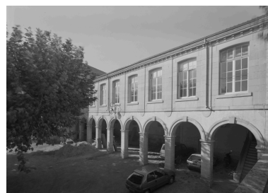
Aile droite de la mairie, anciens locaux de l'école
