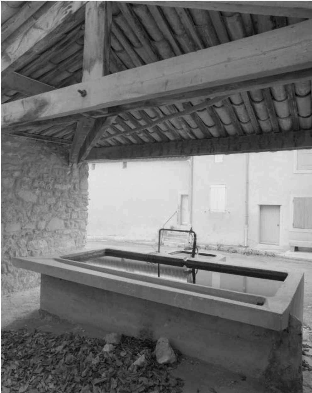
Rousset-les-Vignes. Le lavoir situé près de l'église, récemment restauré.
