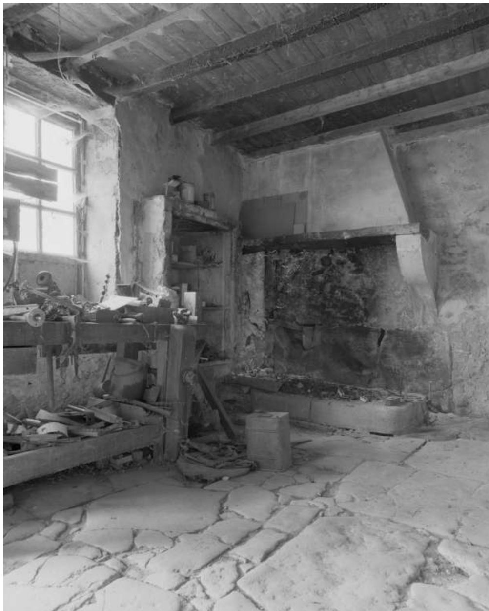
Basses Condamines, chemin de Taulignan aux carrières. Détail de l'ancien logis : cheminée, placard mural et dalles de pierre.
