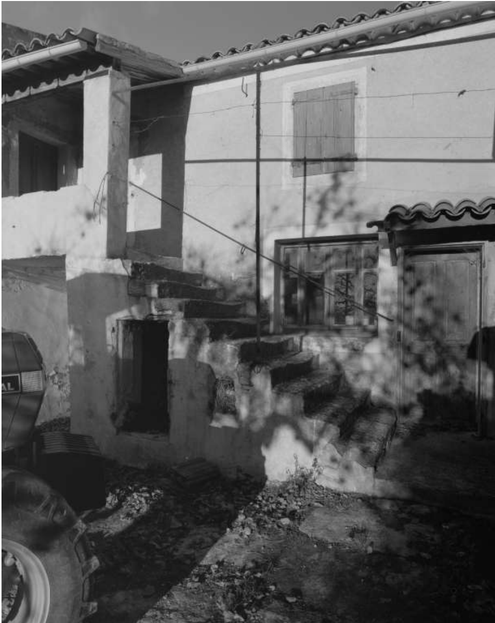
Montbrison, route de Crest (R.D. 538). Logis de la ferme.
