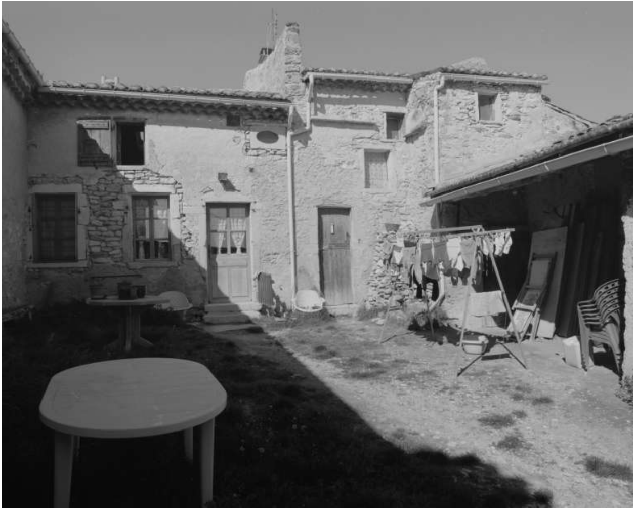
Les Seynières. Elévation principale du logis et dépendances agricoles accolées, donnant sur cour.
