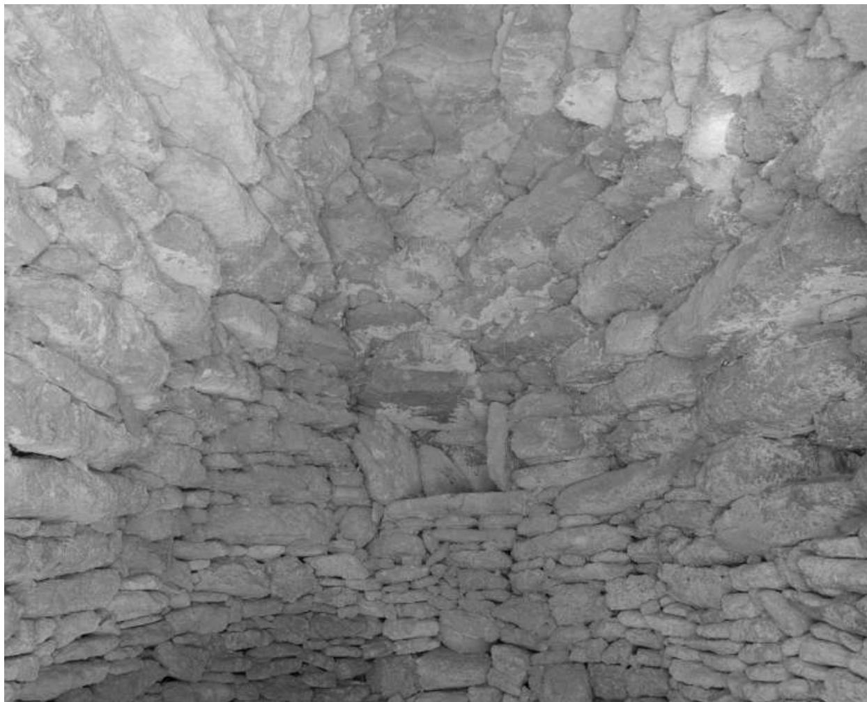
Taulignan, Esclouseau. Couvrement intérieur de la borie : principe de coupole en encorbellement.
