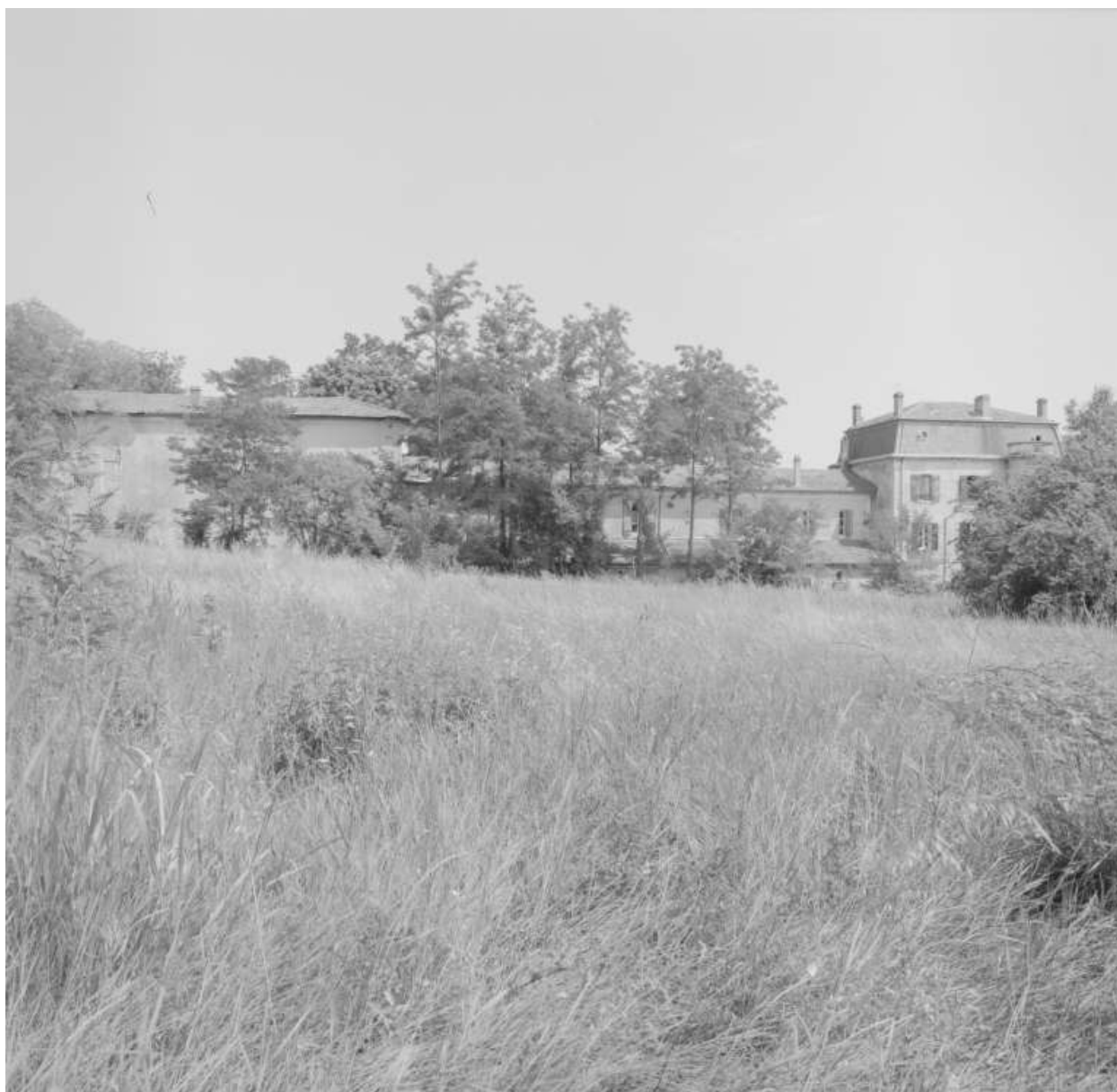
Vue d'ensemble depuis l'ouest : ateliers, chapelle, logement des religieuses et maison de maître.
