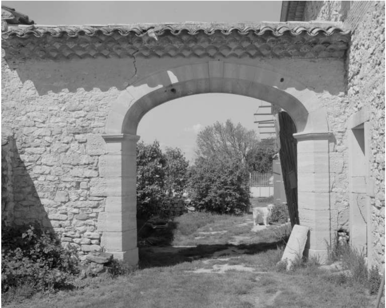
Les Condamines (C1 59). Portail d'entrée sur cour.
