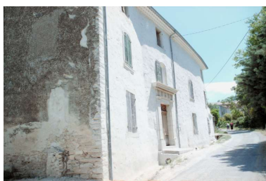
Les Achaux, chemin des Pises (D1 1185). Maison de maître, vue de trois-quarts. Phot. Geneviève Jourdan IVR82_20042600209ZE
