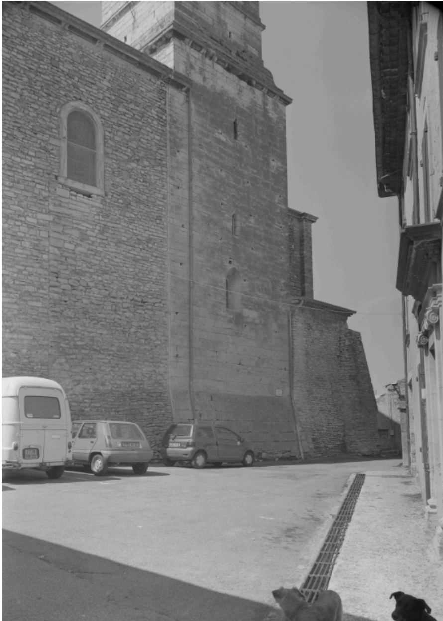
Elévation latérale nord, détail : partie inférieure du clocher.
