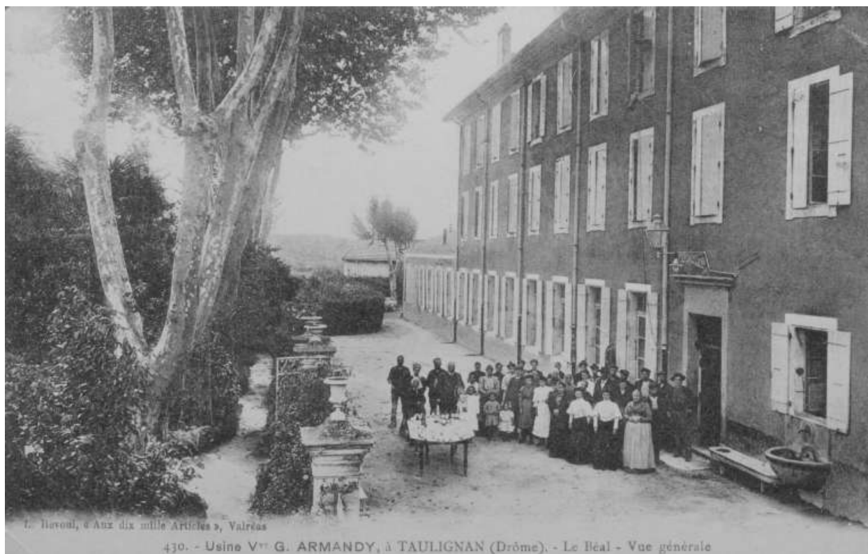
430. - Usine Vve G. ARMANDY, à TAULIGNAN (Drôme). Le Béal - Vue générale.
