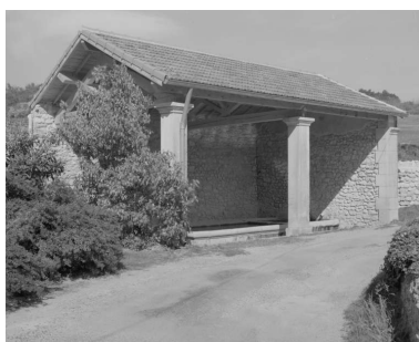
Roussas. Le Village, montée de la Calade. Vue de trois quarts du lavoir communal, dit du Haut. Phot. Alain Franchella, Phot. Martial Couderette IVR82_20002600282X
