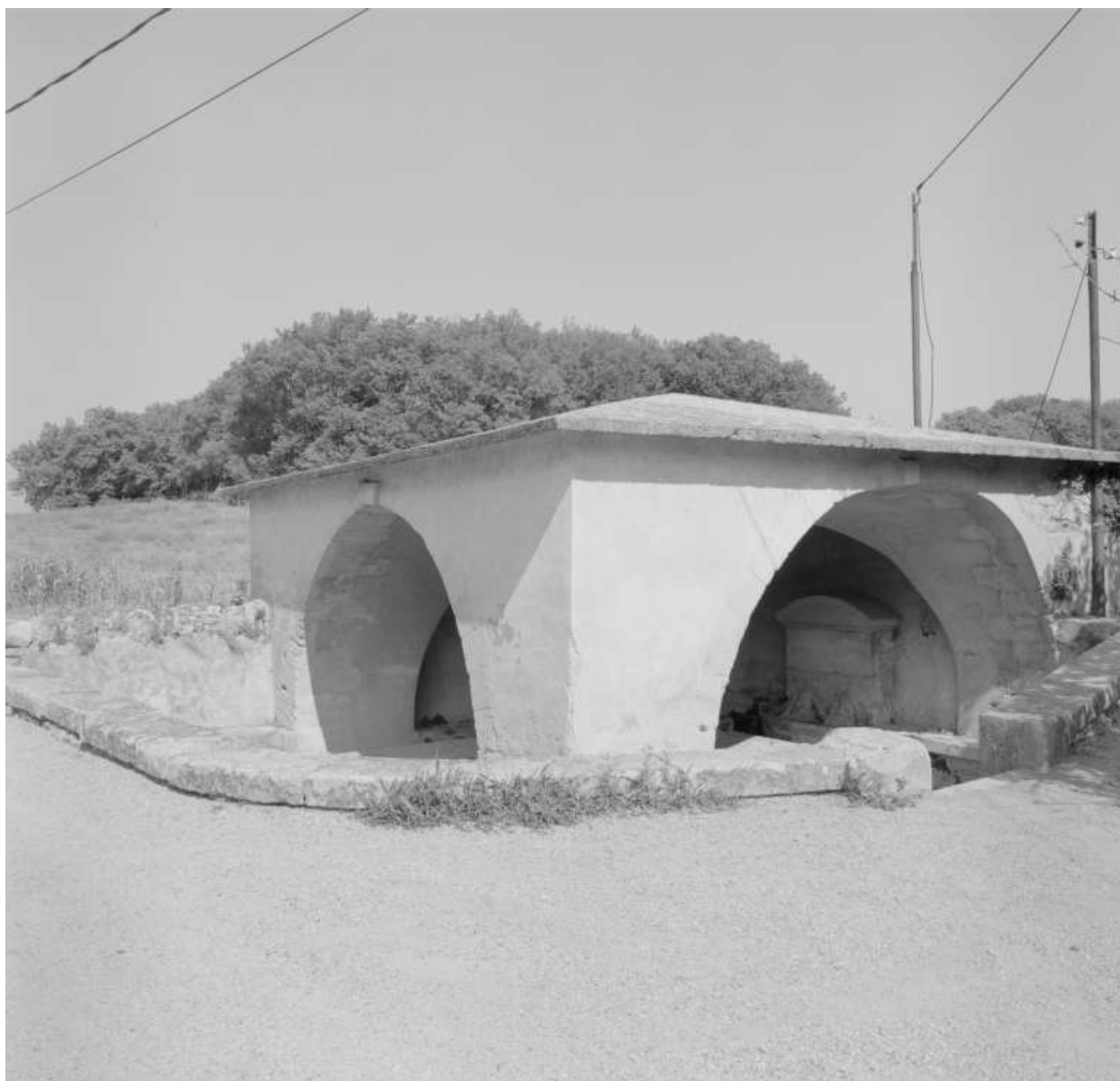
Chamaret. Le Colombier. Vue générale du lavoir dit la grande fontaine.
