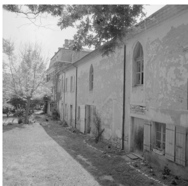
Aile ouest, élévations sur jardin : vue partielle de la chapelle, logement des religieuses et maison de maître.
