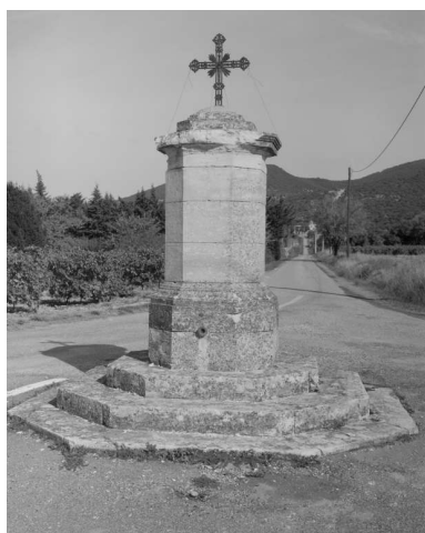
Montbrison-sur-Lez, le Châtelard, C. D. 238. Vue générale de la croix du carrefour, avec croisillon d'origine en fonte (1865). Phot. Alain Franchella IVR82_19982600572X
