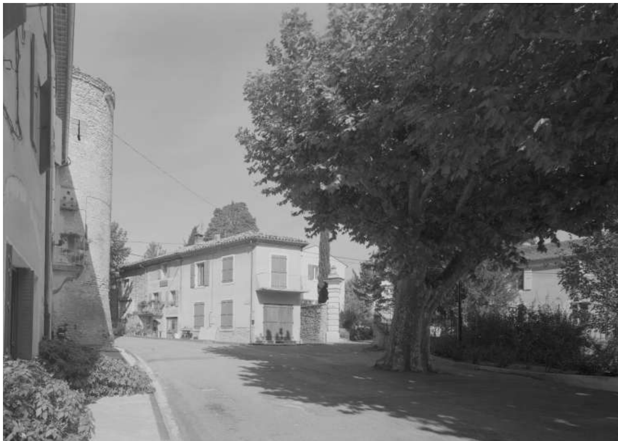
Place de la République, et rue des Petits Remparts : sur la gauche, l'une des 11 tours de la fortification, munie d'une archère canonnière.
