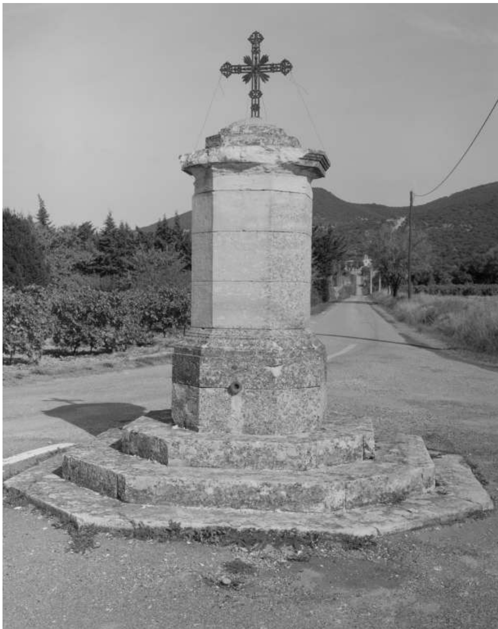
Montbrison-sur-Lez, le Châtelard, C. D. 238. Vue générale de la croix du carrefour, avec croisillon d'origine en fonte (1865).
