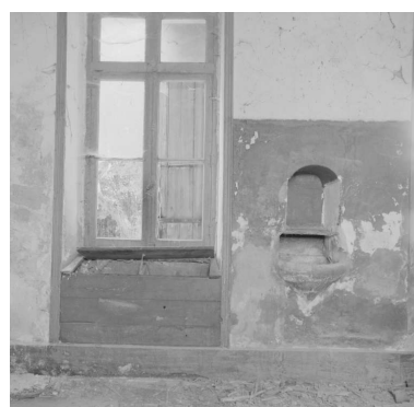
Vue intérieure des ateliers, détail : niche et lavabo. Phot. Eric Dessert IVR82_20002600743X
