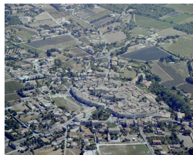
Vue aérienne, prise du sud-ouest. Phot. Alain Franchella IVR82_20002601263XE
