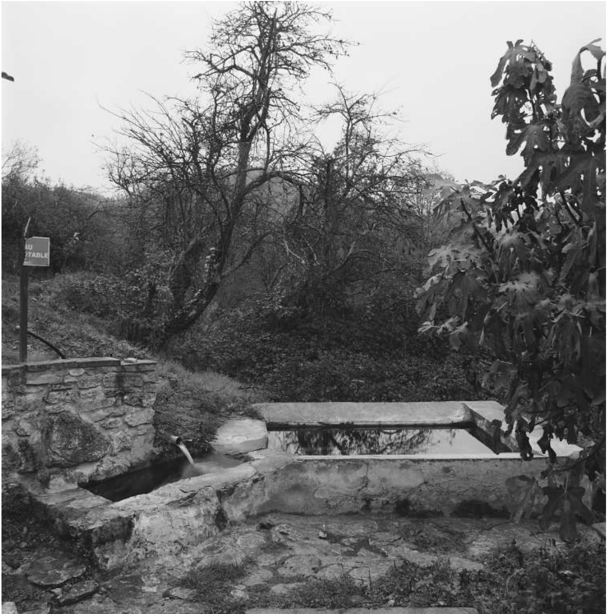
Montjoyer. Hameau de Citelles. Vue d'ensemble du lavoire à ciel ouvert.
