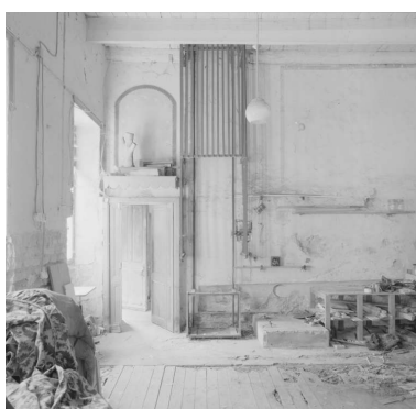
Vue intérieure des ateliers. 1er étage de soubassement, système de monte-charge. Phot. Eric Dessert IVR82_20002600741X
