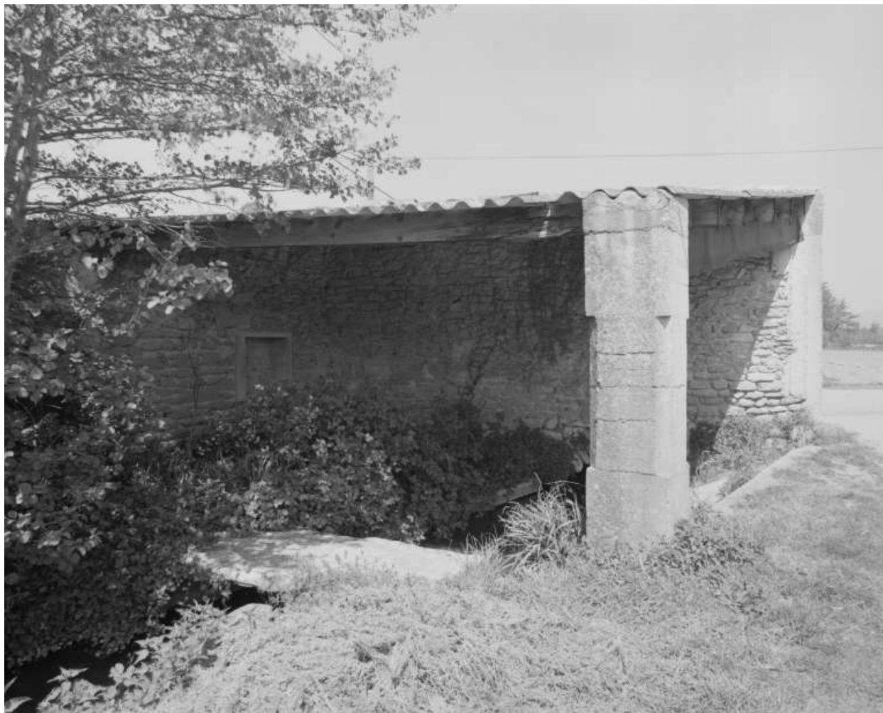
Colonzelle. Le lavoir de Margerie. Vue générale.
