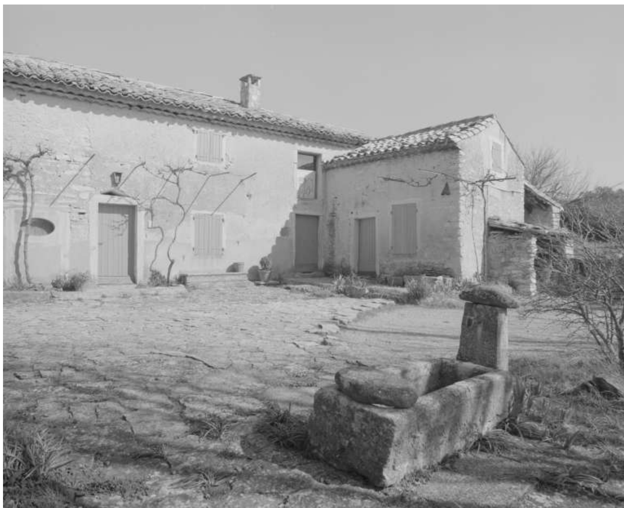
La Garrigue. Vue partielle des élévations sur cour, logis et dépendances.
