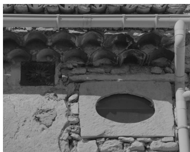
Les Seynières. Elévation principale du logis, détail : oculus et plaque d'assurance de la Compagnie du soleil. Phot. Alain Franchella IVR82_20002600359X
