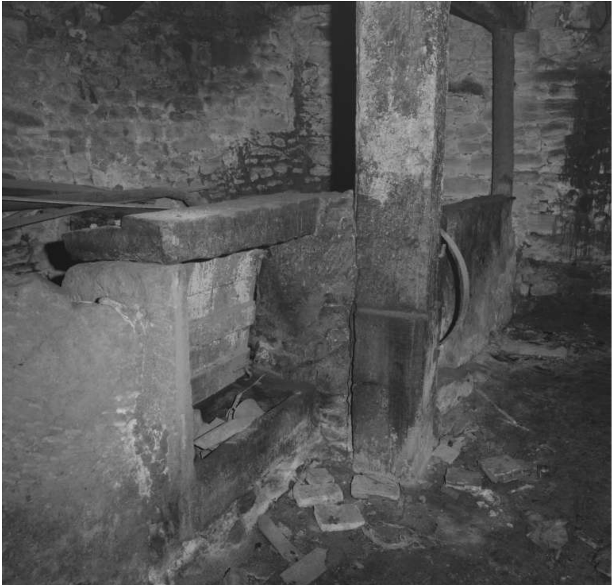
Rue des Fontaines, maison (AX 199). Cuve à vin située dans la cave.
