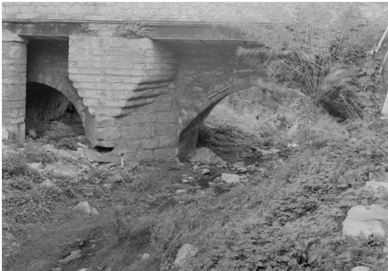
Ancien chemin de Taulignan à Valréas. Pont construit en 1913 sur le canal de la Rialhe : détail de la pile.
