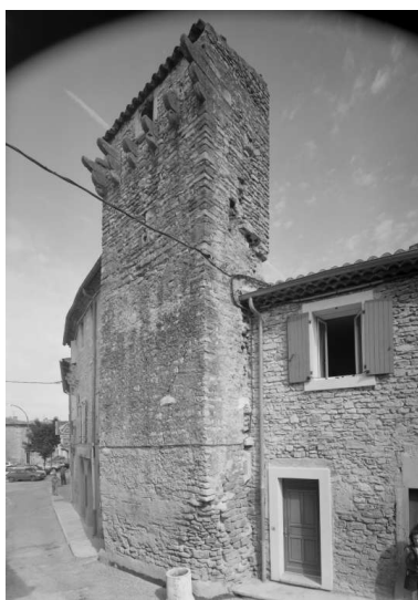
Rue des Grands Remparts. Une des deux tours quadrangulaires flanquées sur la muraille de fortification. Phot. Eric Dessert IVR82_20002601139P
