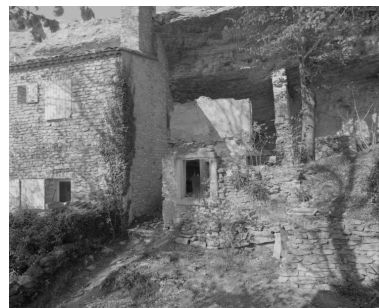
Les Corps Neufs (D 992). Élévation principale. Phot. Alain Franchella IVR82_20002600342X
