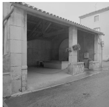
Réauville. Village. Vue d'ensemble du lavoir. Phot. Alain Franchella IVR82_19992600587X
