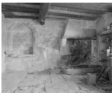
Basses Condamines, chemin de Taulignan aux carrières. Vue intérieure de l'ancien logis, au sol dallé en pierre : évier, cheminée, placard mural. Phot. Alain Franchella, Phot. Martial Couderette IVR82_20002600265X
