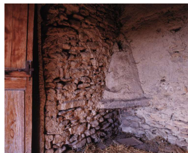
Basses Condamines, chemin vicinal de Taulignan aux carrières. Ancienne magnanerie - fenil, détail d'une cheminée d'angle.
