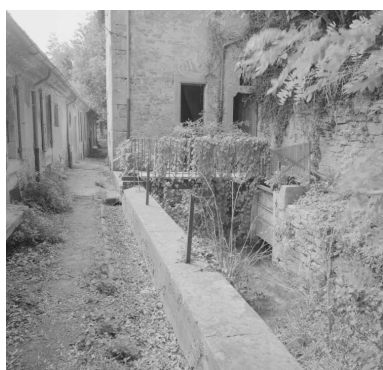
Vue partielle du canal et de l'écluse ; la passerelle au-dessus du canal donne accès au moulin. Phot. Eric Dessert IVR82_20002600720X
