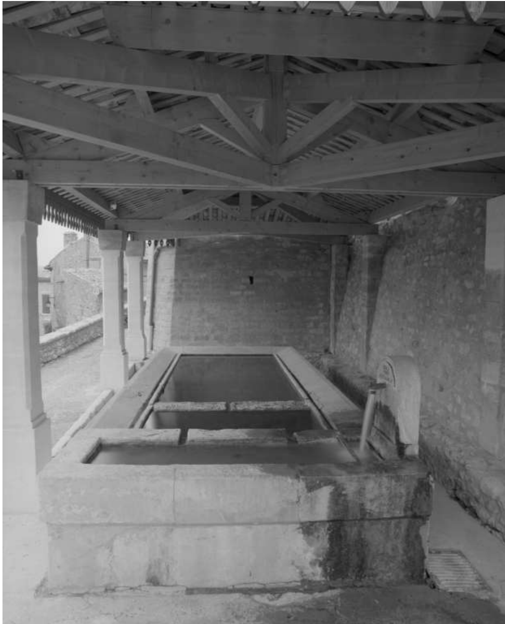
Le lavoir de Valaurie, vue de l'intérieur.
