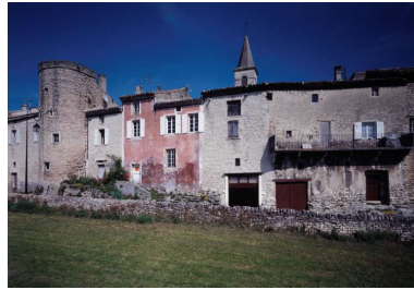
Façade postérieure des maisons adossées aux murailles de fortification et l'une des onze tours. Phot. Eric Dessert IVR82_20002601135PA
