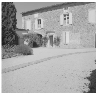
L'Ecluse. Vue partielle du moulinage. Phot. Eric Dessert IVR82_20002600666X
