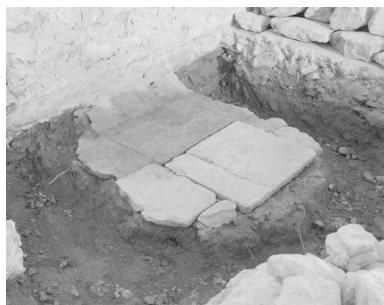
Le Béal. Moulinage : ancien sol en dalles de pierre reposant sur de l'argile. Phot. Eric Dessert IVR82_20002600686X
