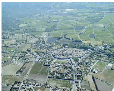
Vue aérienne, prise du sud-ouest. Phot. Alain Franchella IVR82_20002601267XE
