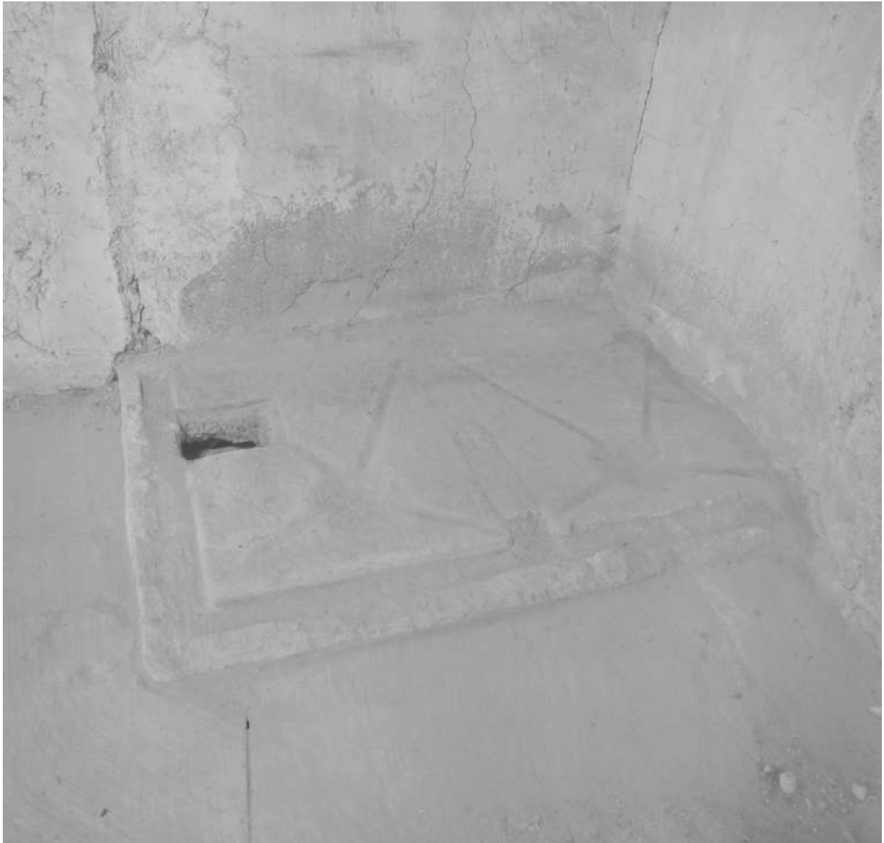
Rue du Coulard, rue de la Poste, maison (AX 100). Caves : dalle de pierre percée permettant l'écoulement du vin vers les cuves.
