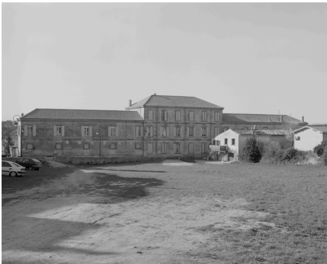
Vue de la façade postérieure.
