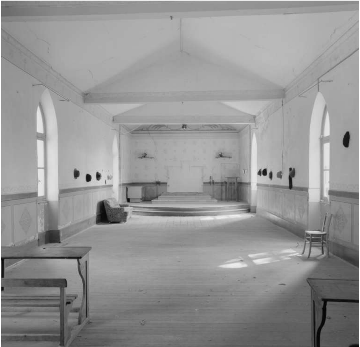
Vue intérieure de l'ancienne chapelle.
