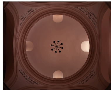
Coupole, vue d'ensemble. Phot. Alain Franchella IVR82_20002600430XA
