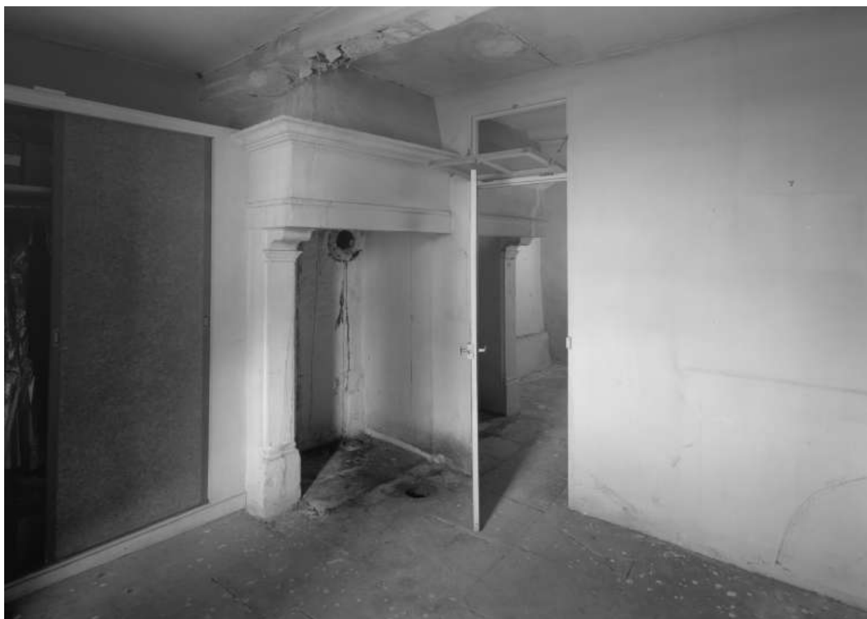
Rue du Coulard, rue de la Poste, maison (AX 100). Pièce de l'ancien logis, qui a conservé ses dalles de pierres.
