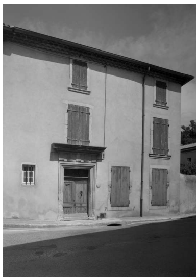
Ancien chemin de Taulignan à Valréas : un ancien moulinaige, où toutes les machines sont encore conservées à l'intérieur. Phot. Eric Dessert IVR82_20002601146P
