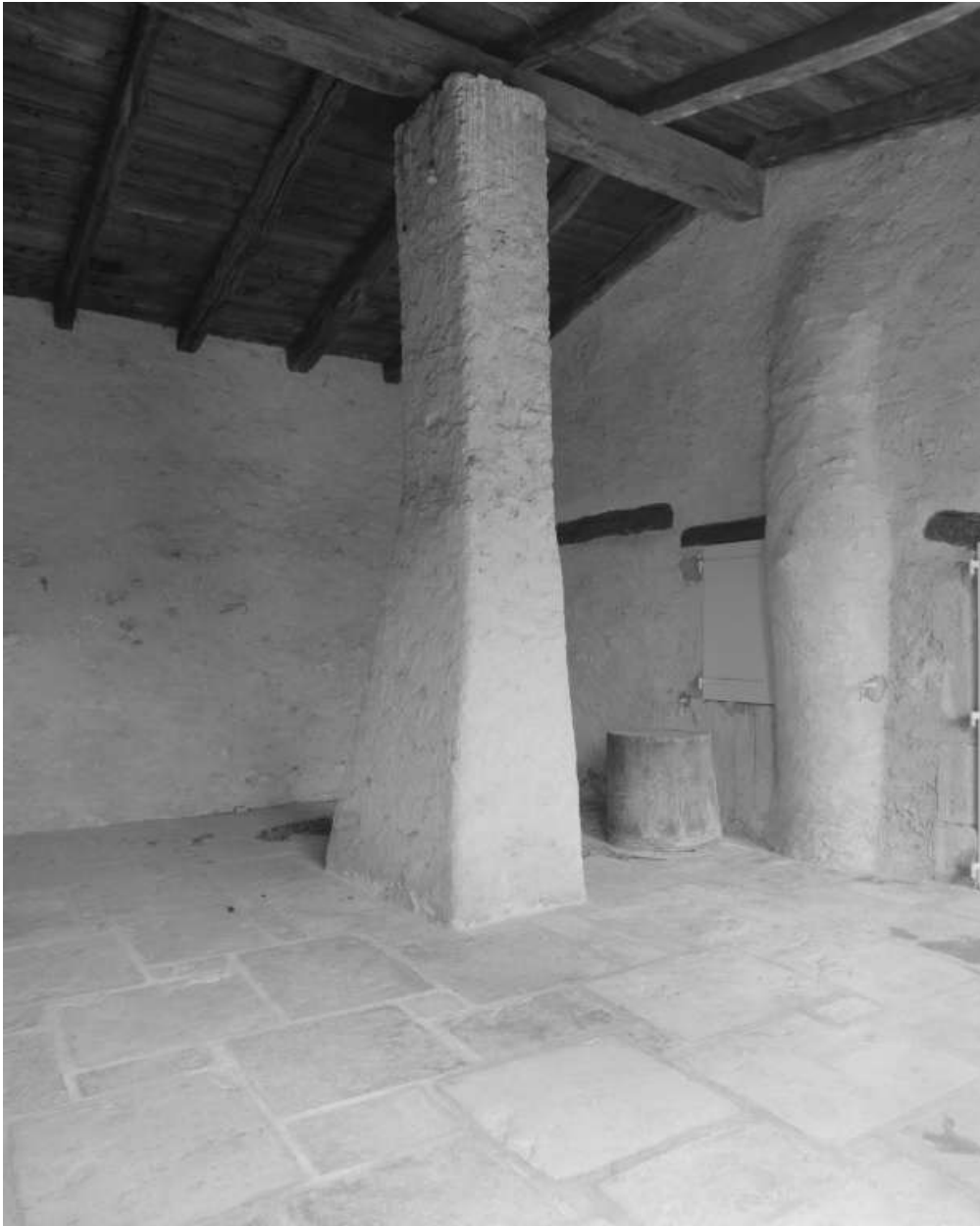
Chèvre, chemin de Taulignan au Poët-Laval. Pilier soutenant la charpente.
