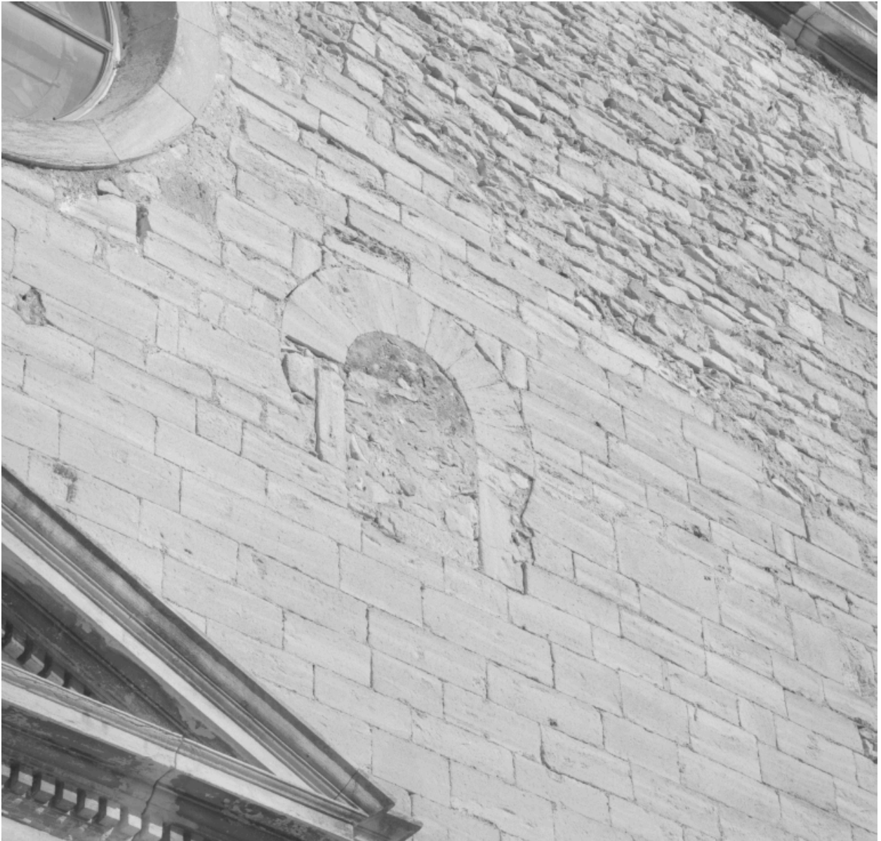
Détail de la façade ouest : fenêtre romane murée.
