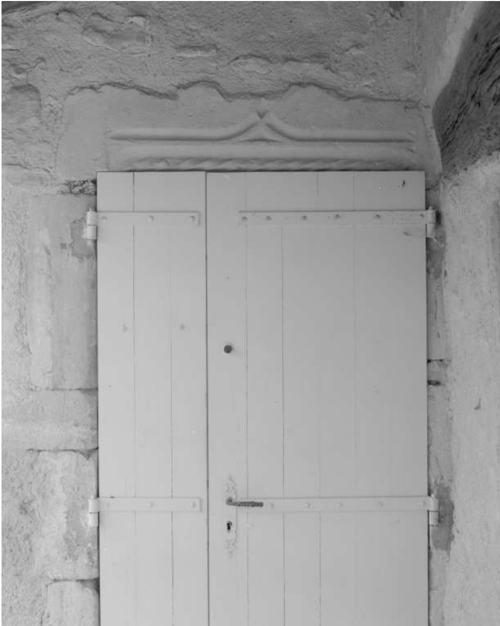
Chèvre, chemin de Taulignan au Poët-Laval. Porte d'entrée sur la galerie : détail du linteau orné d'une accolade et de moulures.
