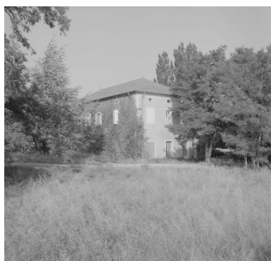
Voie communale n°2 de Grillon à Taulignan. Vue de l'ancienne fabrique dite "usine brûlée".
