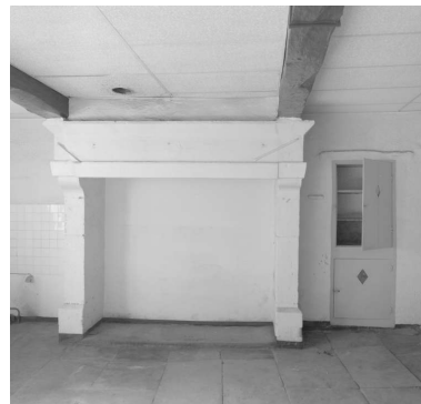
Rue du Coulard, rue de la Poste, maison (AX 100). Ancienne cuisine, au sol dallé en pierre. Il ne reste plus que la cheminée et le potager dans un placard mural.
