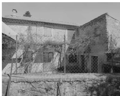
Taulignan. Vue sur la cour d'une ferme, du côté de Grange Blanche. Phot. Alain Franchella IVR82_20002600340X
