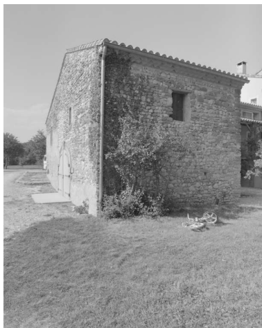
Les Planches, quartier Béal. Dépendance agricole, vue de trois quarts. Phot. Eric Dessert IVR82_20002600675X
