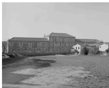
Vue de la façade postérieure.
