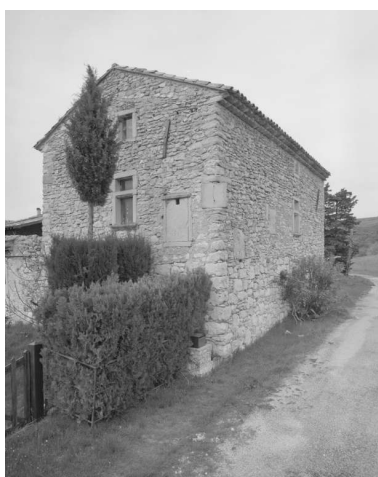
Quartier Rousselle (A3 530). Vue de trois quarts de l'ancien logis, devenu dépendance agricole. Phot. Alain Franchella IVR82_20002600394X
