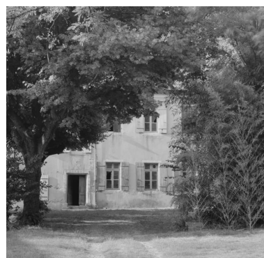
Aile nord, entrée des ateliers de moulinage. Phot. Eric Dessert IVR82_20002600732X
