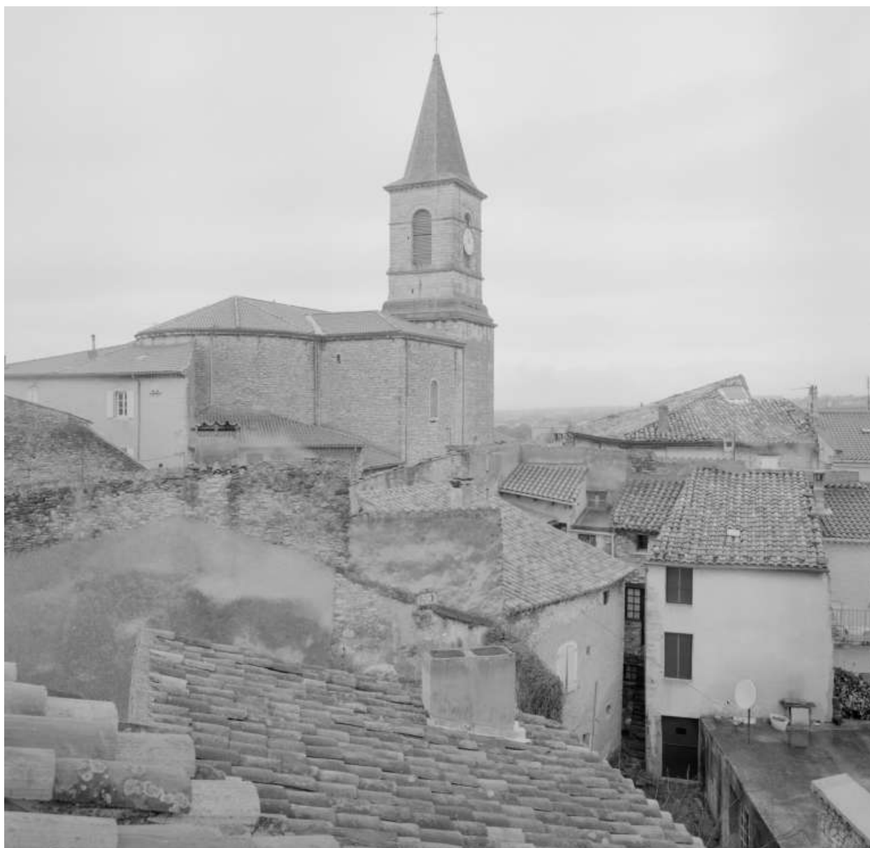
Vue de l'église, côté nord-est, et des toits des maisons.
