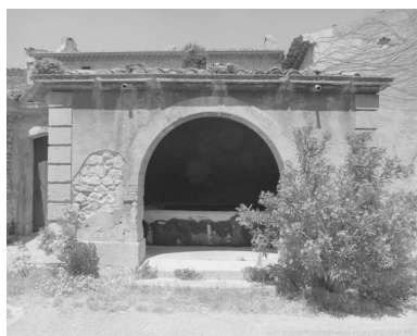
Grignan. Hameau de Bayonne. Vue du lavoir public. Phot. Alain Franchella IVR82_20002600649X
