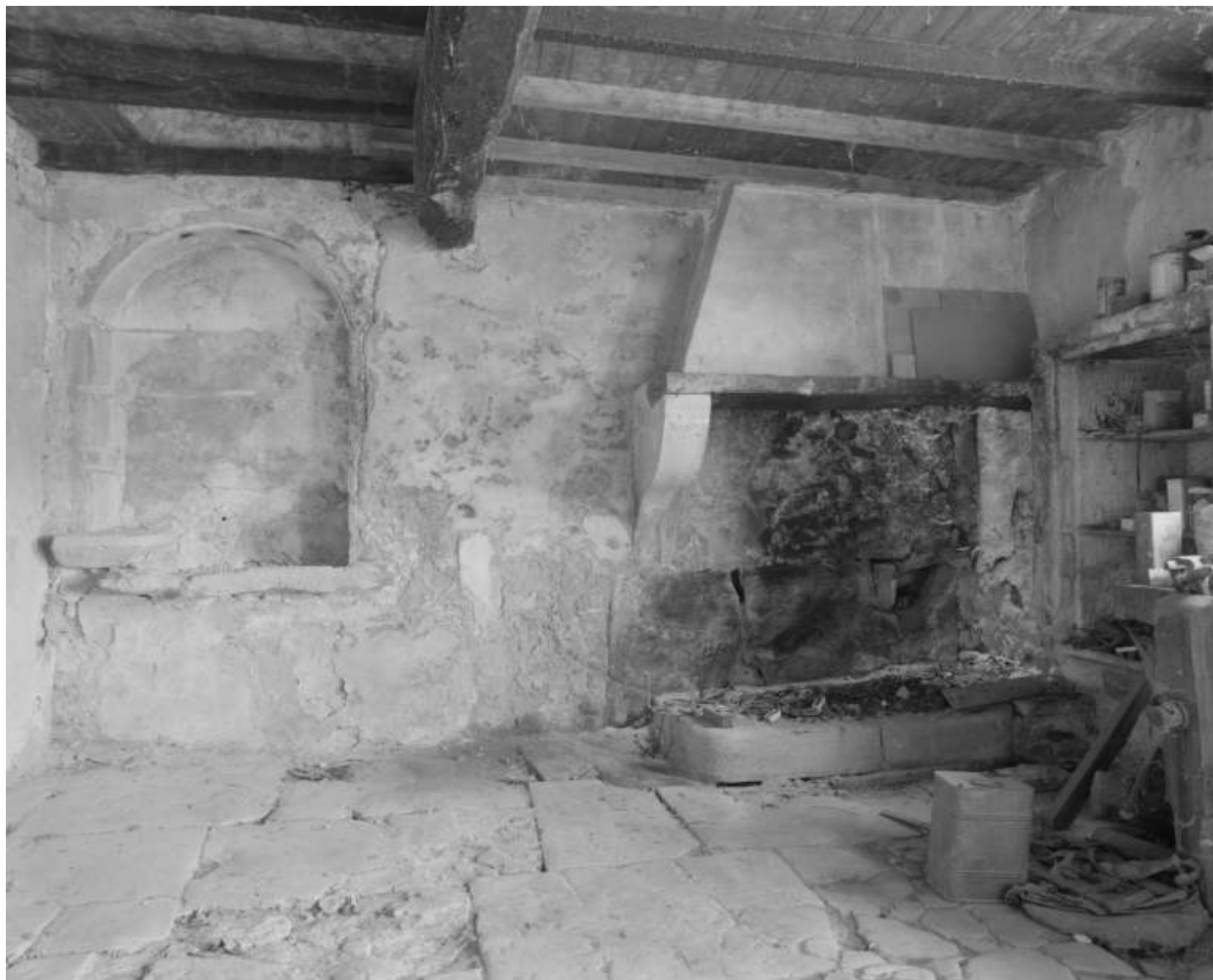
Basses Condamines, chemin de Taulignan aux carrières. Vue intérieure de l'ancien logis, au sol dallé en pierre : évier, cheminée, placard mural.
