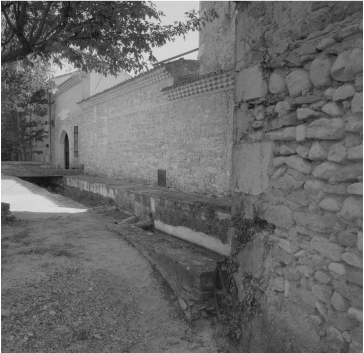
L'Ecluse. Vue partielle du canal et entrée de l'ancien moulinage dit usine de l'Ecluse, actuellement monastère de la Clarté Notre-Dame.
