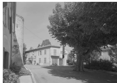
Place de la République, et rue des Petits Remparts : sur la gauche, l'une des 11 tours de la fortification, munie d'une archère canonnrière. Phot. Eric Dessert IVR82_20002600920P
