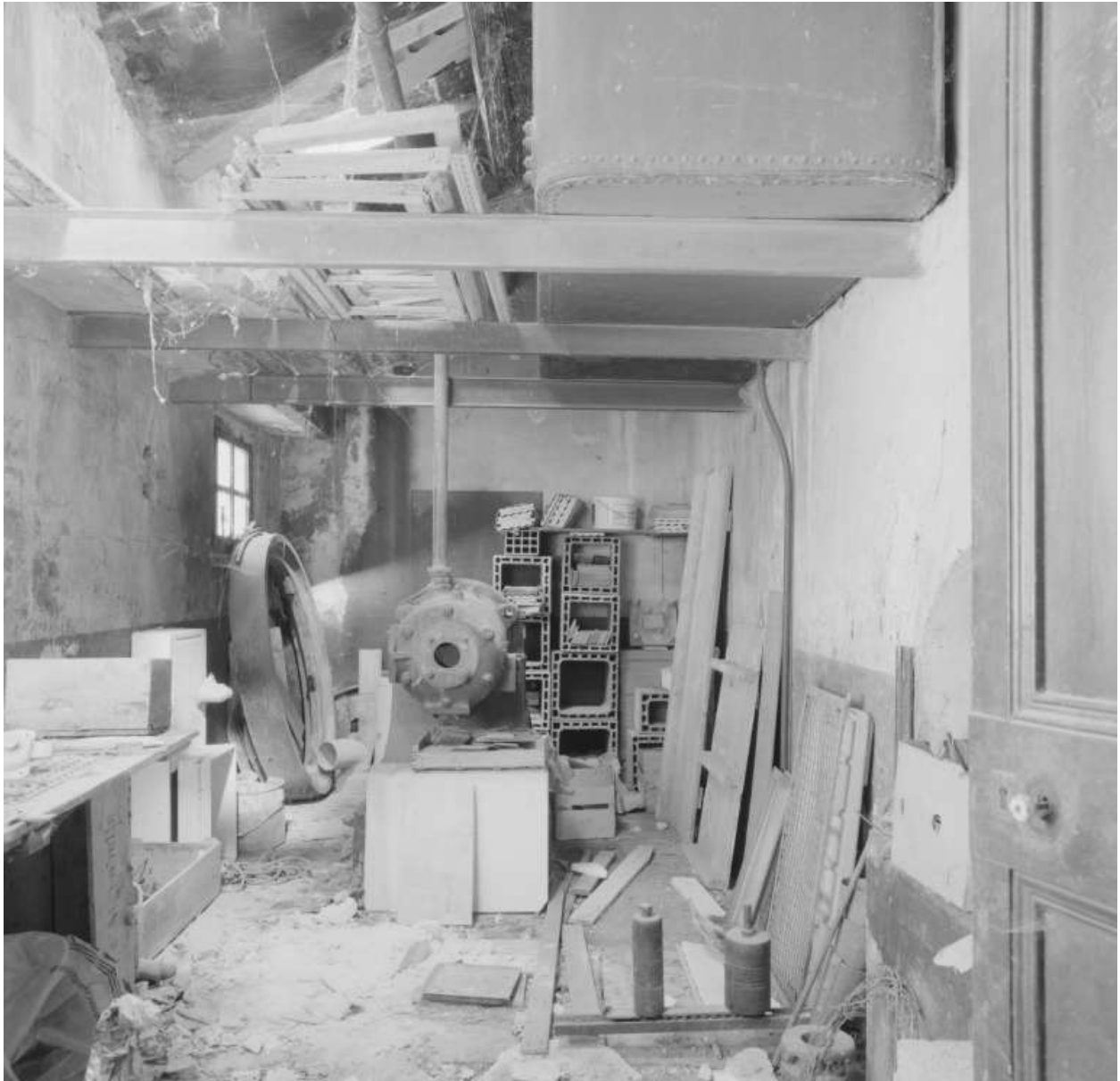
Dispositif (turbine) relié à une pompe, situé au-dessus des ateliers.
