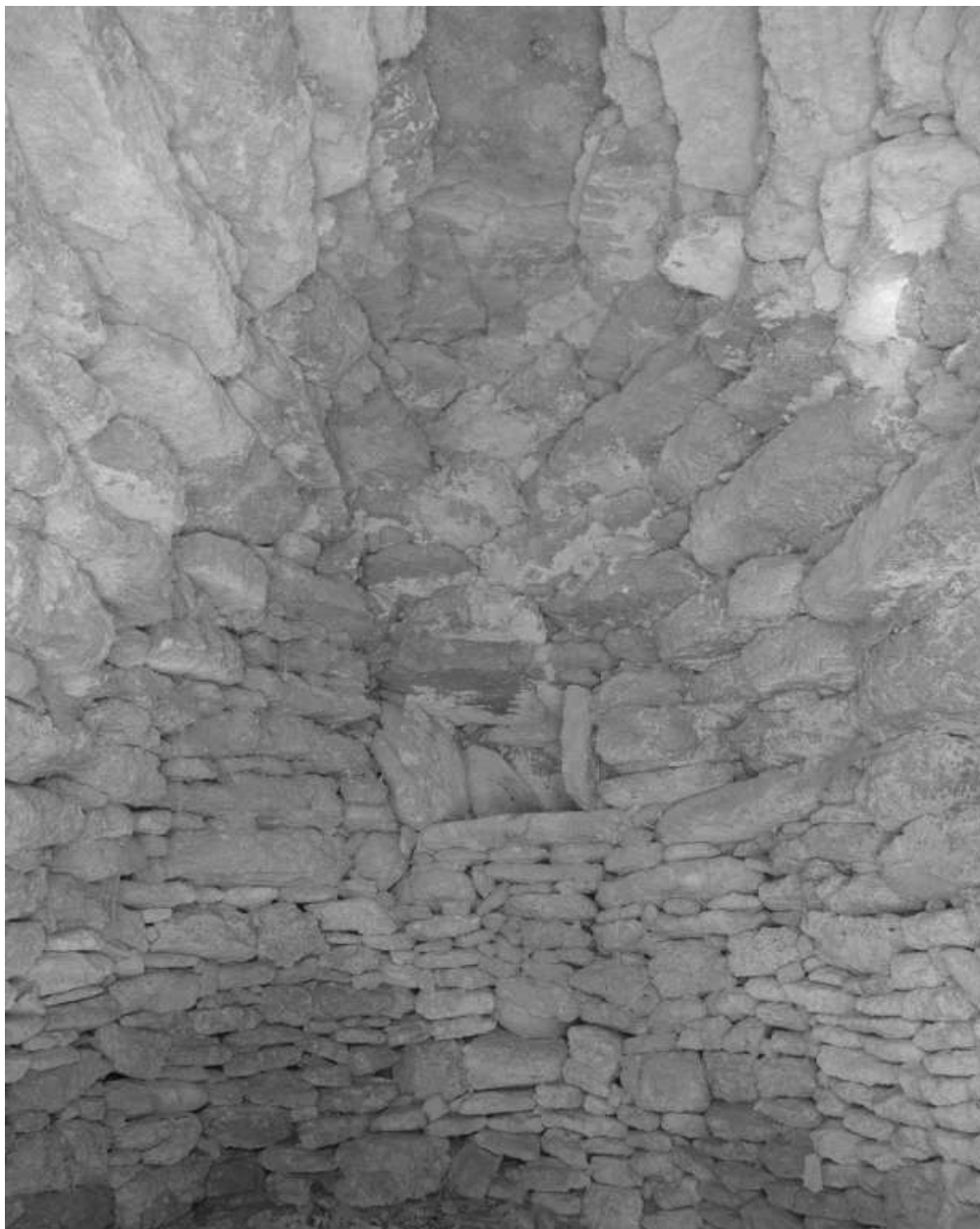
Taulignan, Esclouseau. Couvrement intérieur de la borie : principe de la coupole en encorbellement.
