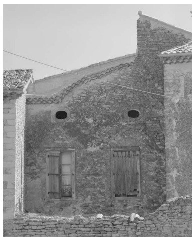
Les Achaux, chemin des Pises (D1 1185). Maison de maître, vue partielle d'une élévation latérale. Phot. Alain Franchella IVR82_20002600400X
