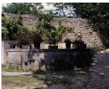
Le Béal. Ancienne citerne à gaz, transformée en bassin.
