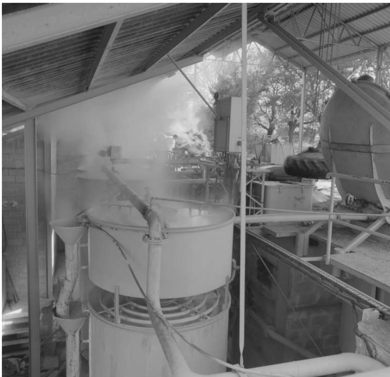
Grignan. Distillerie en activité : détail des cuves à vapeur permettant d'obtenir de l'essence de lavandin.
