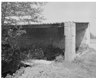
Colonzelle. Le lavoir de Margerie. Vue générale. Phot. Alain Franchella IVR82_19972600210X
