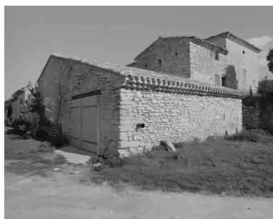
Pontaujas. Elévation latérale de la maison et dépendances. Phot. Alain Franchella IVR82_20002600348X
