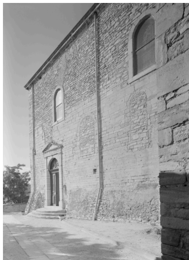
Elévation latérale sud, vue partielle, montrant les reprises de construction. Phot. Jean-Marie Refflé IVR82_20002600824P
