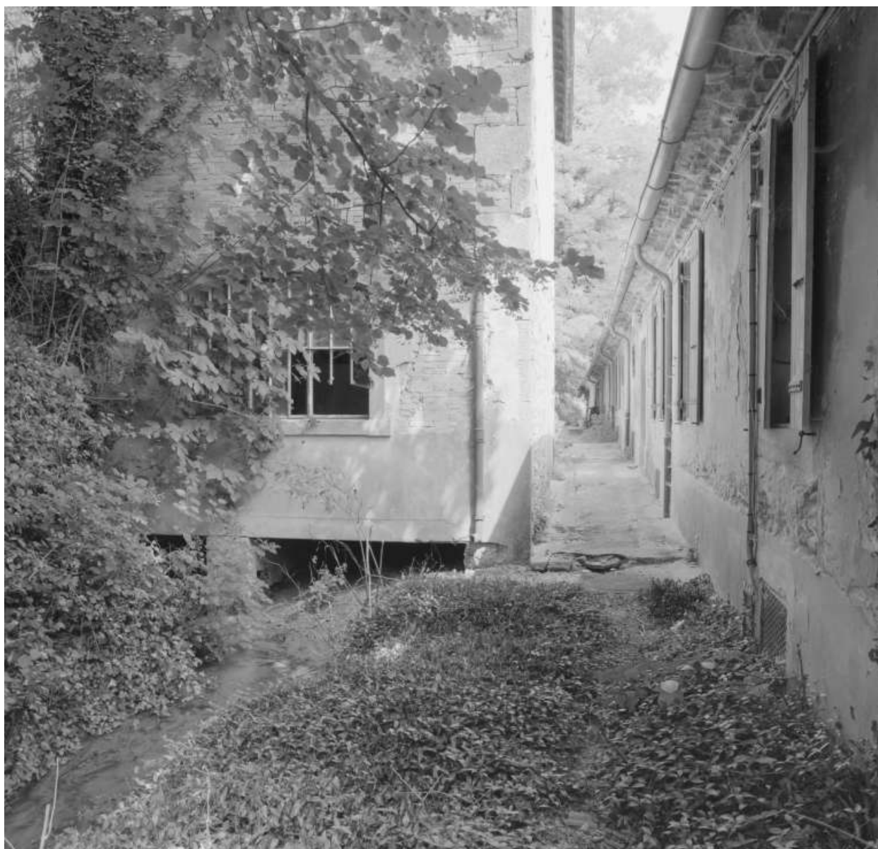
Vue partielle du moulin, à gauche, construit au-dessus du canal. En face, élévation postérieure de l'aile nord : niveau du logement des ouvrières situé au-dessus des ateliers.
