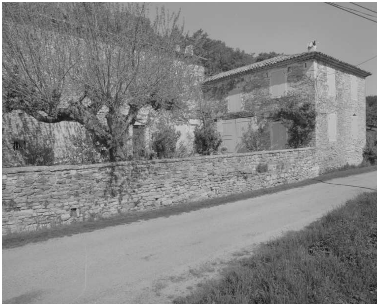
La Tourtelle ( E1 270 ). Vue d'ensemble des élévations, donnant sur cour fermée.
