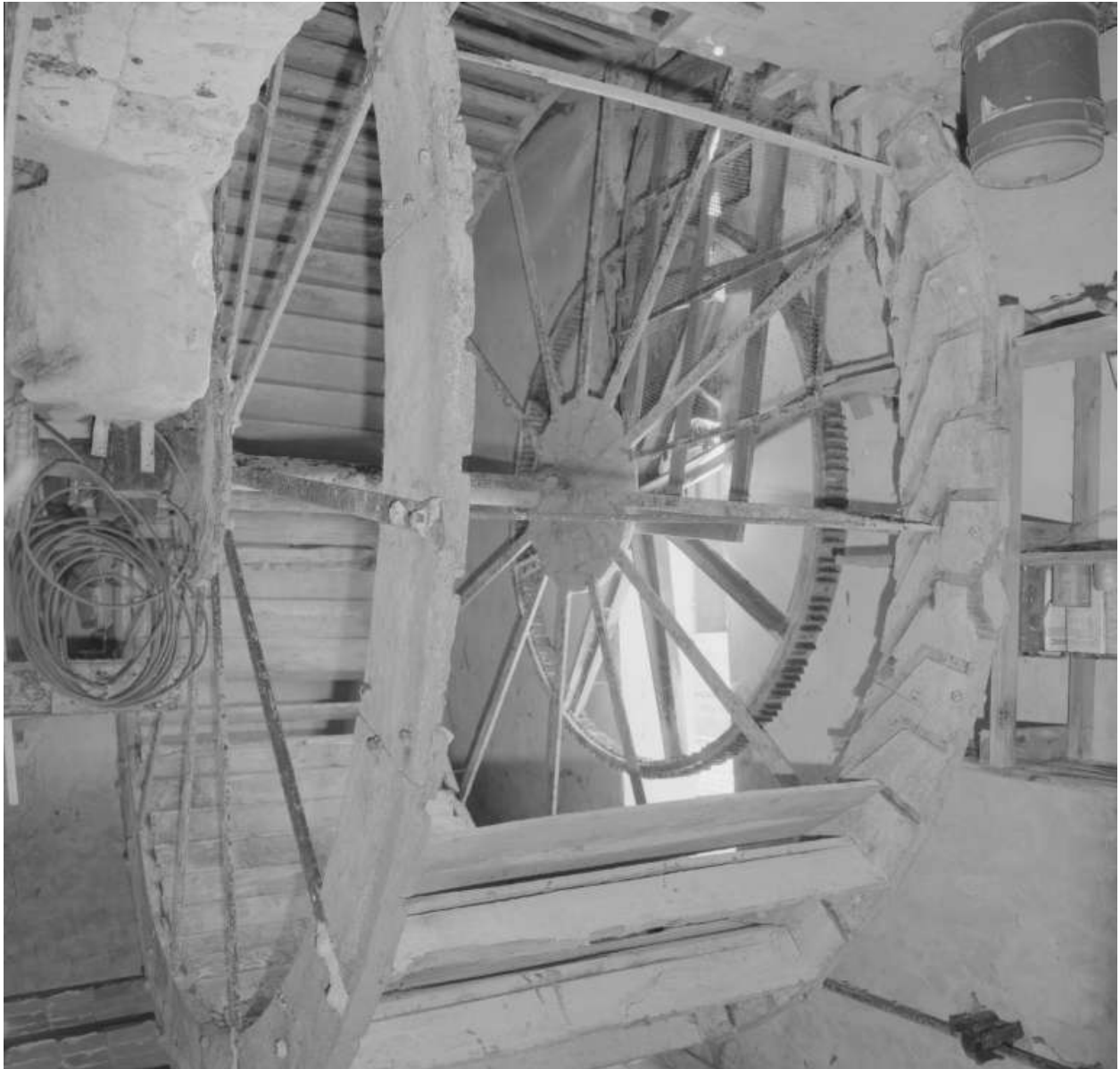
Moulin : la roue située à l'intérieur et actionnée par l'eau du canal.
