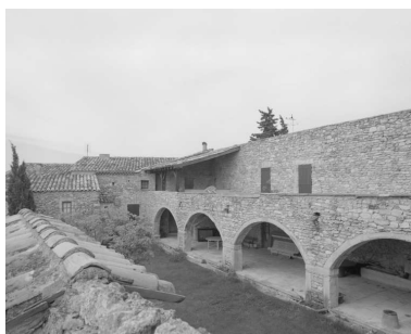
Quartier Rousselle (A3 530), ferme. Vue d'ensemble depuis l'est. Phot. Alain Franchella IVR82_20002600396X
