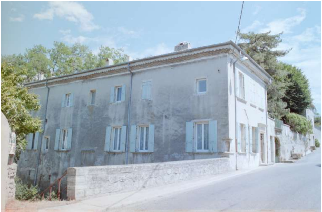
Route de Valréas. Vue d'ensemble de la maison du peintre Patricot (AM 169, type 5) : façade sur rue et élévation latérale sur le canal de la Rialhe.
