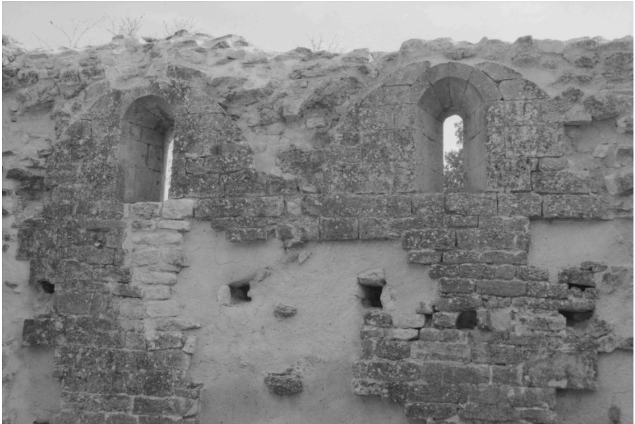
Baies en plein cintre, percées dans le mur sud.
