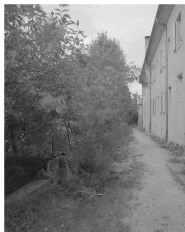
Le Béal. Moulinage. Elévation postérieure des ateliers. Phot. Eric Dessert IVR82_20002600681X
