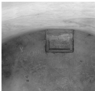
Chamaret. Le Colombier. Détail de l'inscription et date 1781 dans le lavoir dit "la grande fontaine". Phot. Alain Franchella IVR82_19992600244X
