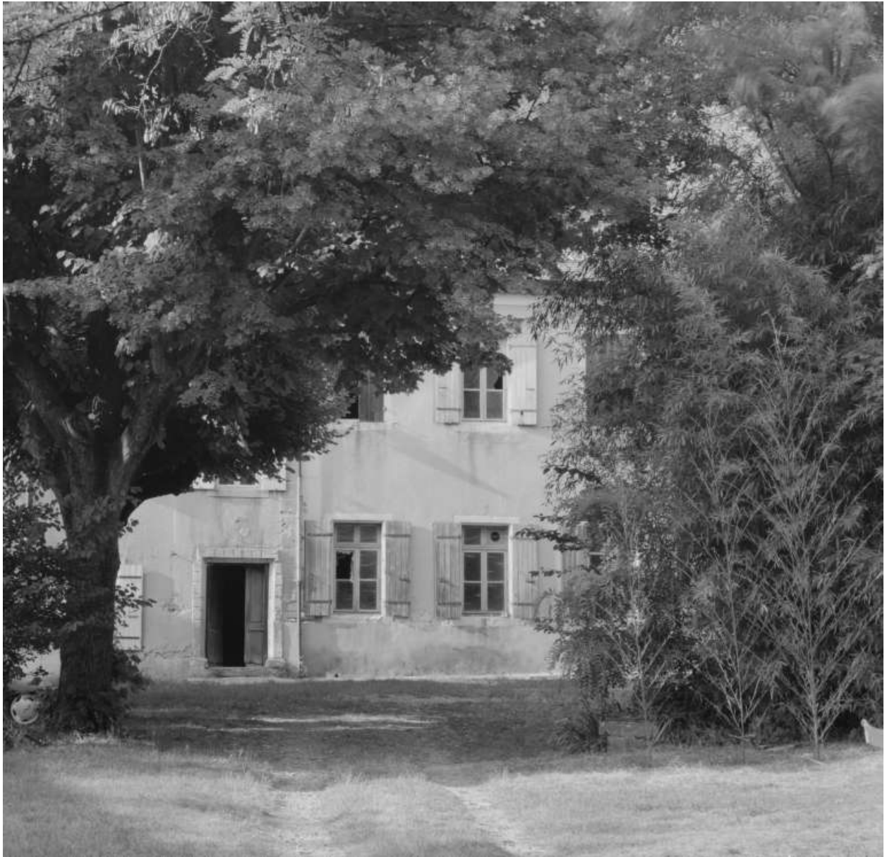
Aile nord, entrée des ateliers de moulinage.
