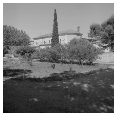
L'Ecluse. La chapelle de l'ancienne usine de l'Ecluse, aujourd'hui du monastère de la Clarté Notre-Dame. Phot. Eric Dessert IVR82_20002600658X
