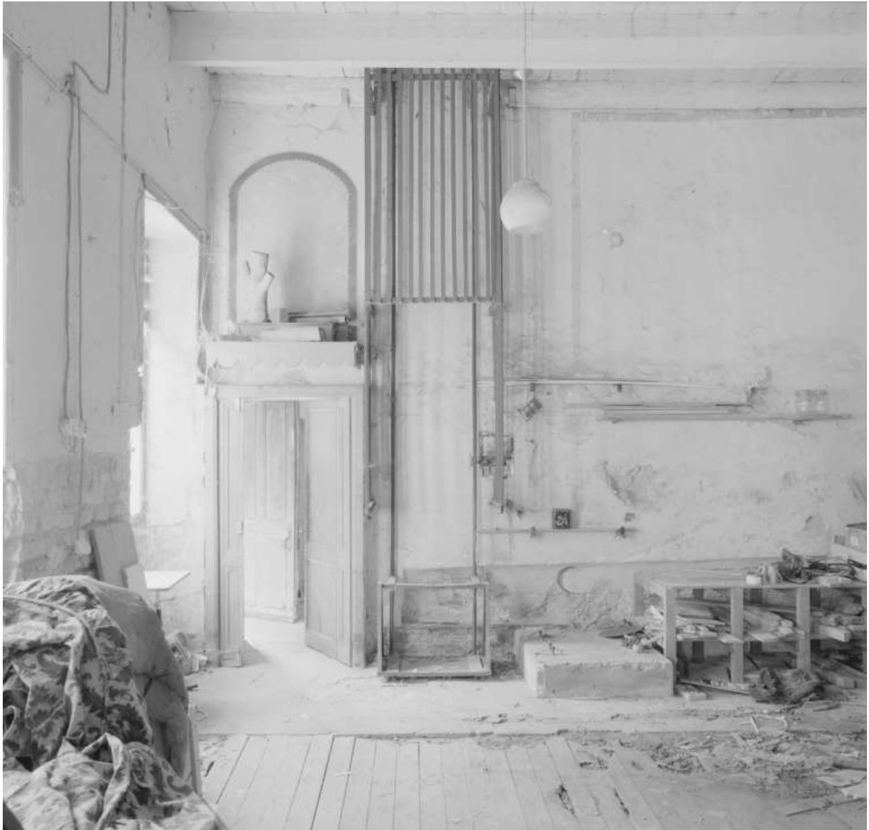
Vue intérieure des ateliers. 1er étage de soubassement, système de monte-charge.
