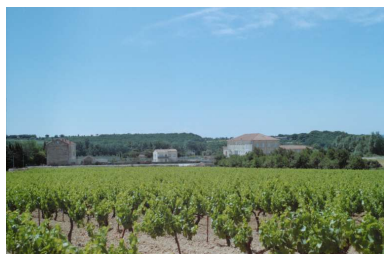
Usine du Pont-du-Lez, puis établissements Pascal, vue d'ensemble depuis le chemin de l'Ecluse. Phot. Geneviève Jourdan IVR82_20042600205ZE
