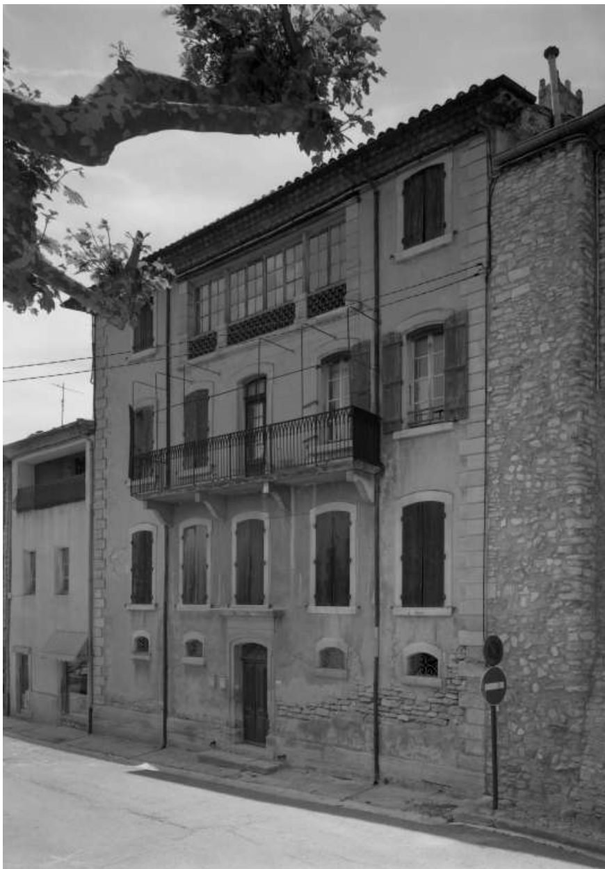
Rue des Remparts (AX 75). Façade de type 4, d'une maison adossée à la courtine, surélevée et remaniée au 19e siècle.
