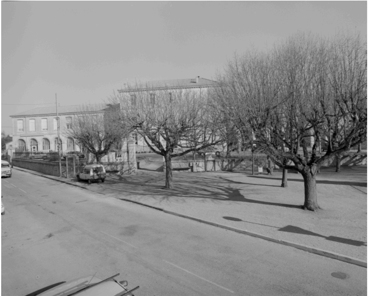
Vue des bâtiments de la mairie-école.
