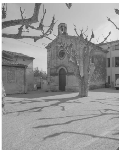
Vue d'ensemble depuis le sud-ouest. Phot. Alain Franchella IVR82_20002600431X
