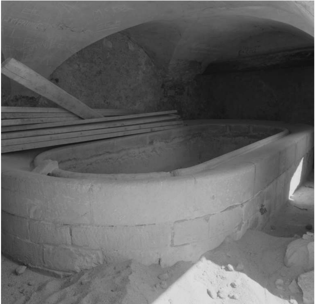
Salles-sous-Bois. Le Village. Grande rue. Vue d'ensemble du bassin du lavoir en restauration.
