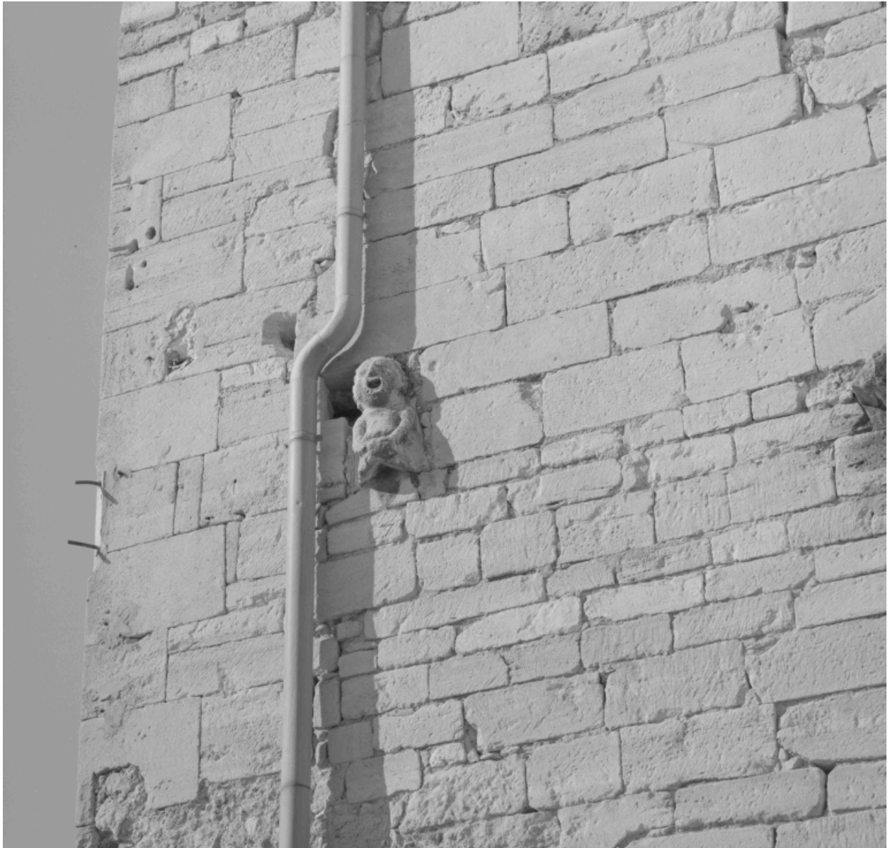
Détail de l'élévation sud, angle ouest : figure en haut-relief (gargouille romane ?), en remploi.
