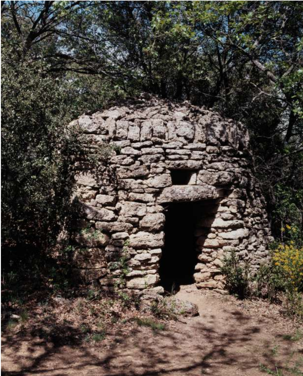
Chamaret. Les Souteras (?). Borie, vue de face.
