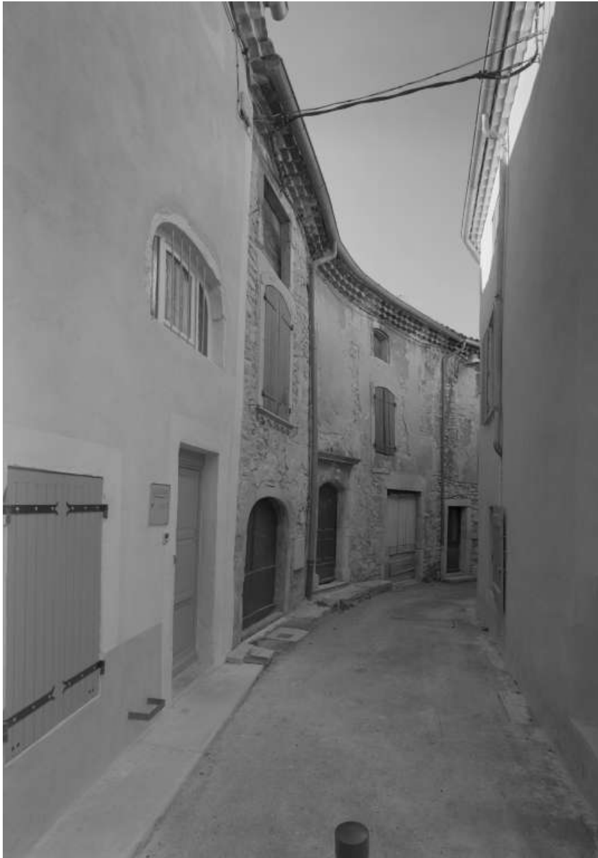
Rue Vieille Mérique, maison de type 6 (AX 18), façade modifiée aux 18e et 19e siècles, porte datée de 1810.
