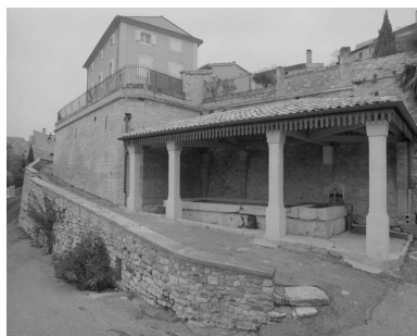
Le lavoir de Valaurie adossé à l'enceinte. Phot. Alain Franchella IVR82_19972600552X
