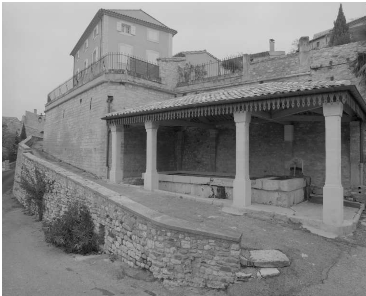
Le lavoire de Valaurie adossé à l'enceinte.
