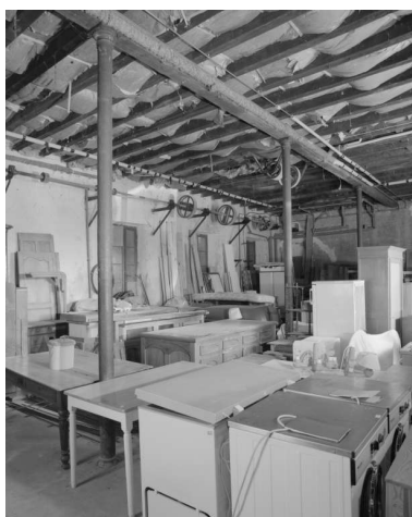
Voie communale n°2 de Grillon à Taulignan. Ancien atelier de la fabrique dite "usine brûlée", vue intérieure.
