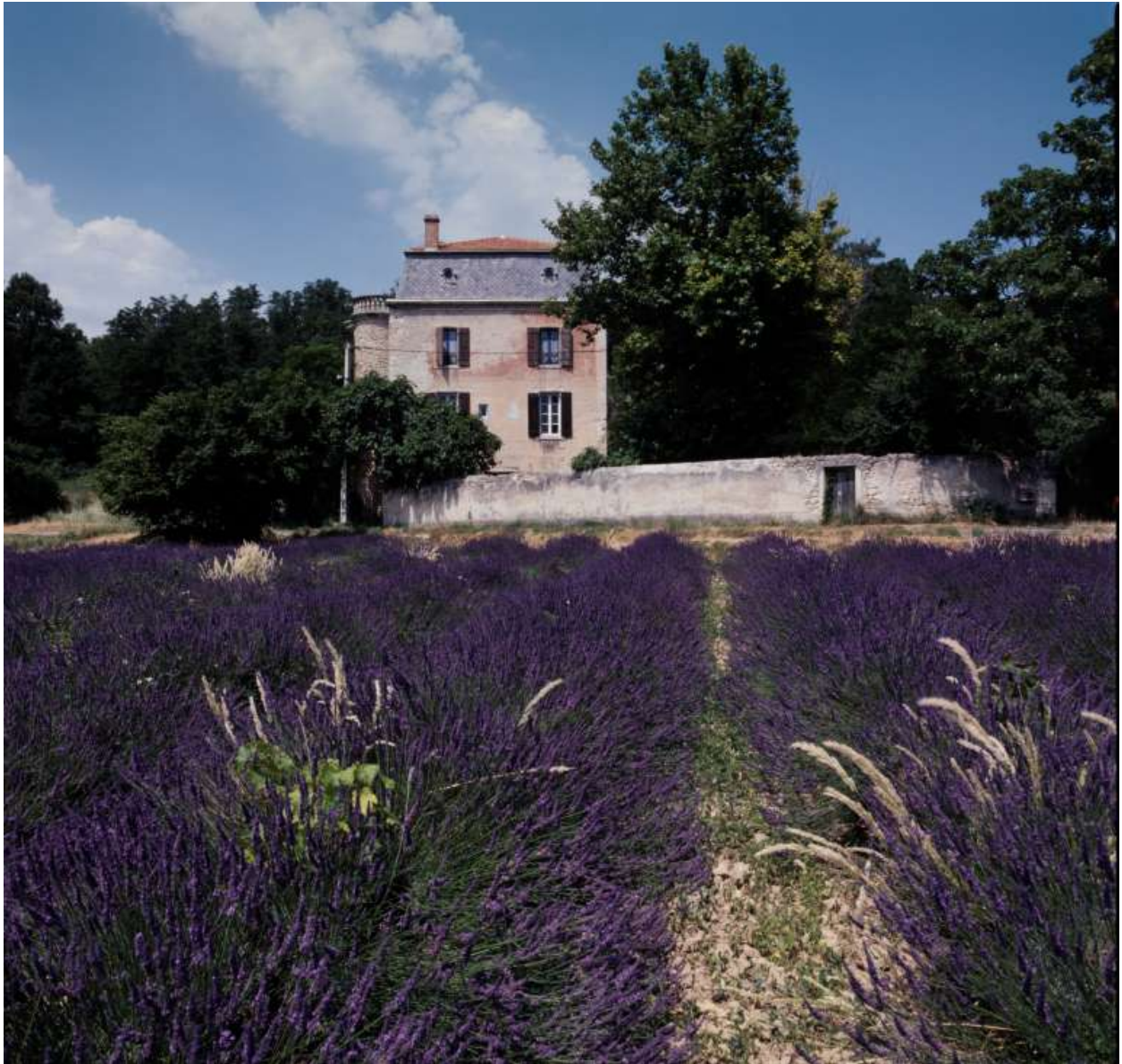
Vue depuis le sud : élévation latérale de la maison de maître et mur de clôture du jardin.
