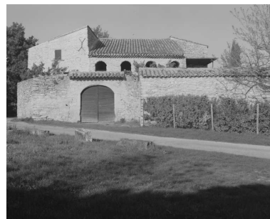
Serret, chemin de l'Alençonne. Vue d'ensemble de l'Alençonne, ancienne ferme et à l'origine léproserie. Phot. Alain Franchella IVR82_20002600351X
