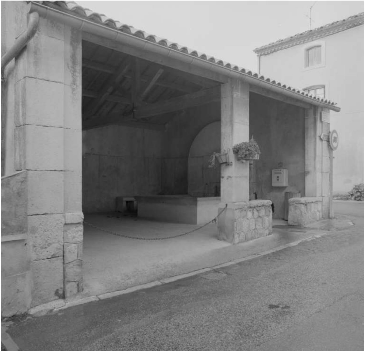
Réauville. Village. Vue d'ensemble du lavoir.
