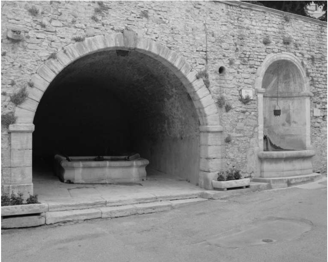
Taulignan. Rue des Fontaines. Vue d'ensemble du lavoire sous voûte et la fontaine associée.
