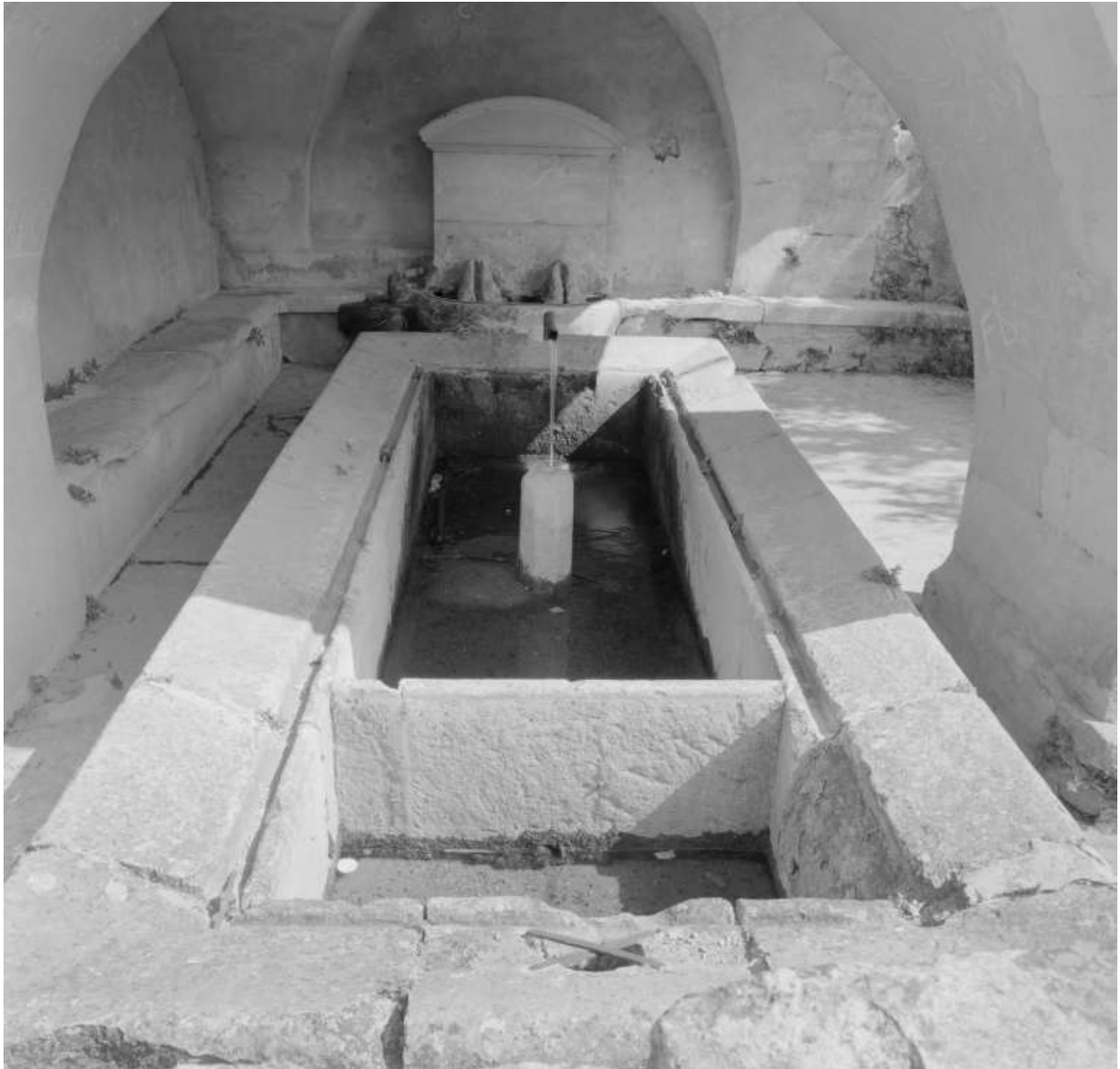
Chamaret. Le Colombier. Vue intérieure du lavoir dit la grande fontaine.
