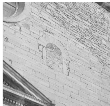
Détail de la façade ouest : fenêtre romane murée. Phot. Jean-Marie Refflé IVR82_20002600826X
