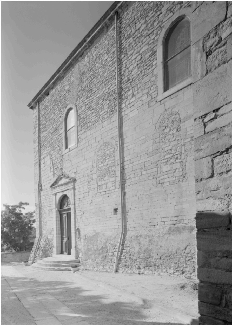
Elévation latérale sud, vue partielle, montrant les reprises de construction.
