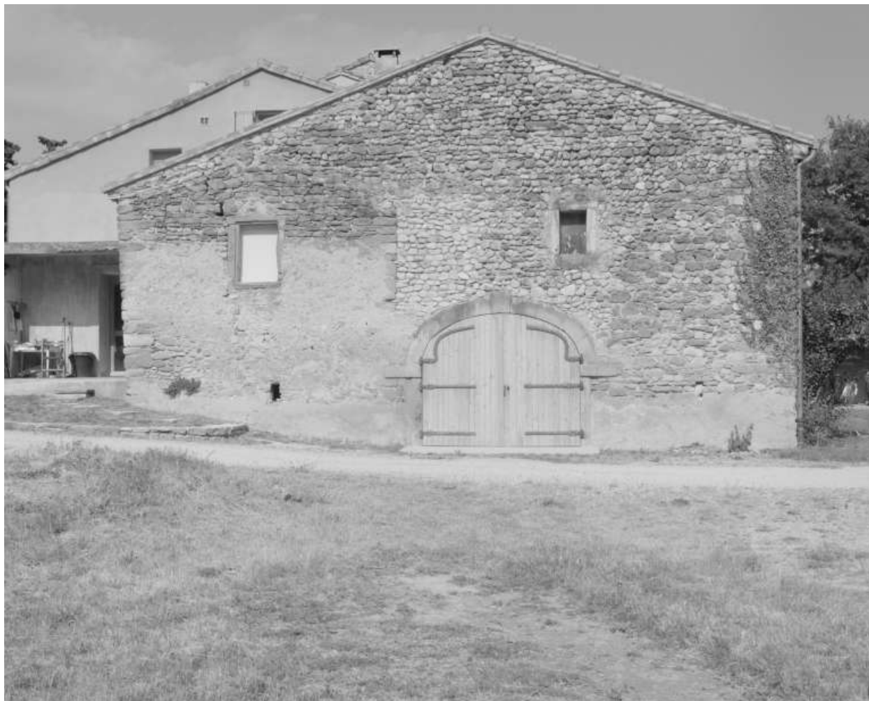
Les Planches, quartier Béal. Dépendance agricole, vue de face.
