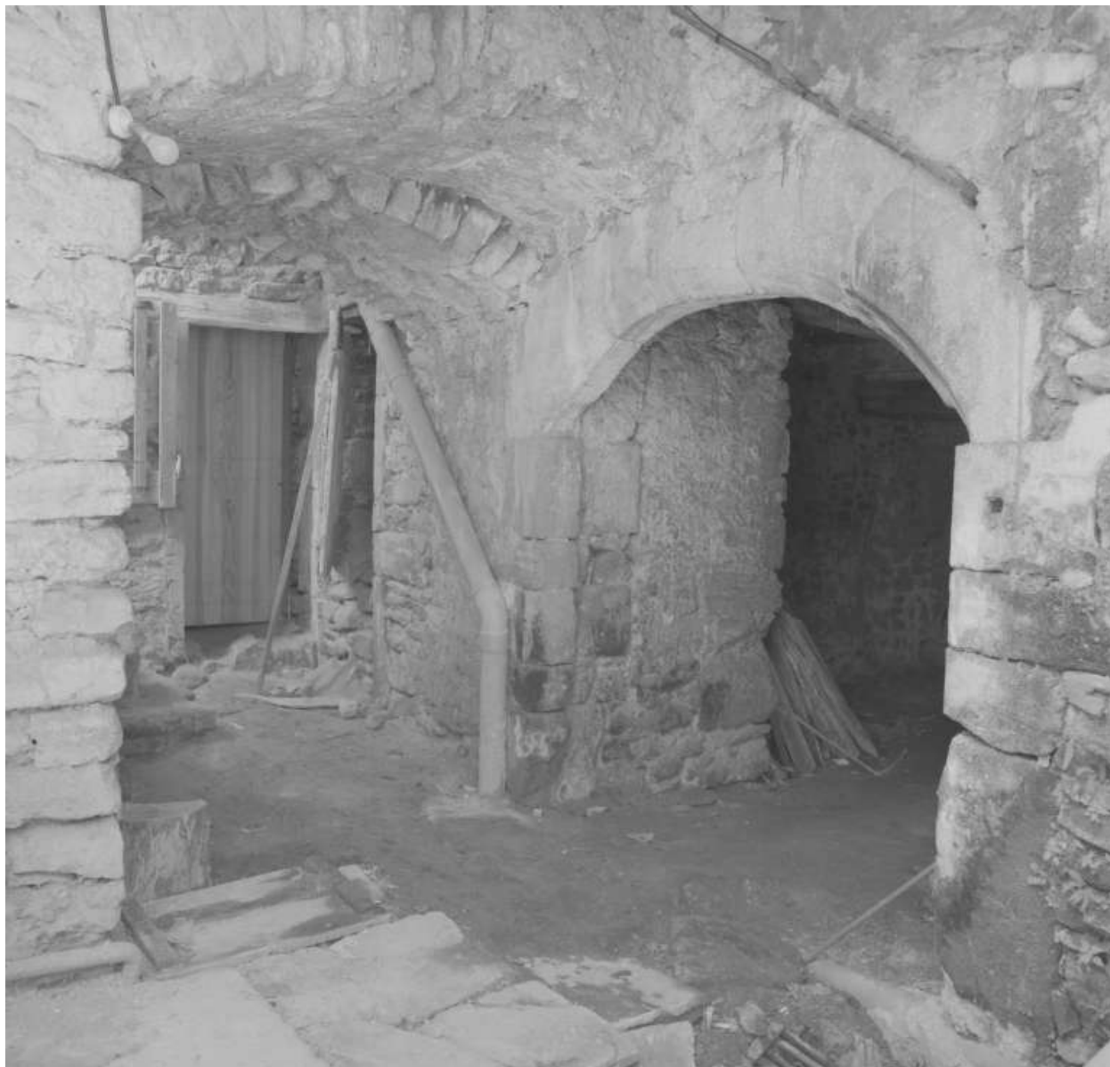
Rue du Coulard, rue de la Poste, maison (AX 100). Caves voûtées en étage de soubassement.
