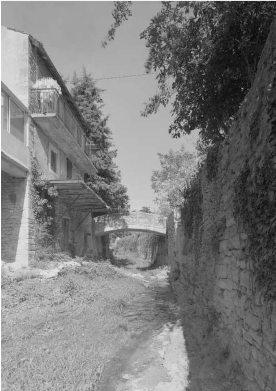
Le Bourg. Canal de la Rialhe qui alimentait les moulins implantés le long de la berge.
