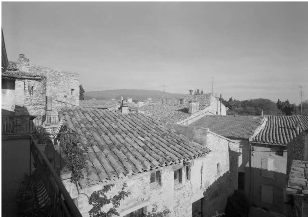
Vue des toits des maisons situées dans le quartier nord-ouest.
