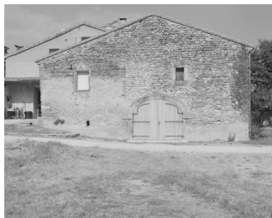
Les Planches, quartier Béal. Dépendance agricole, vue de face. Phot. Eric Dessert IVR82_20002600676X
