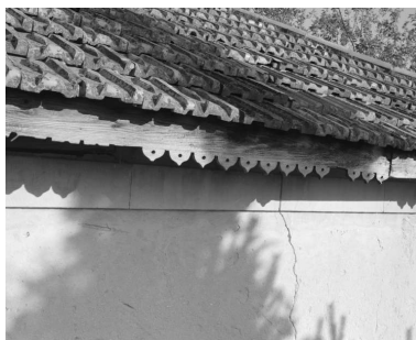
Détail du toit, bordé d'un lambrequin en bois découpé. Phot. Alain Franchella IVR82_19982600454X
