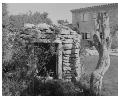
Les Auzières. Puits couvert dans le jardin d'une ferme. Phot. Alain Franchella IVR82_20002600248X
