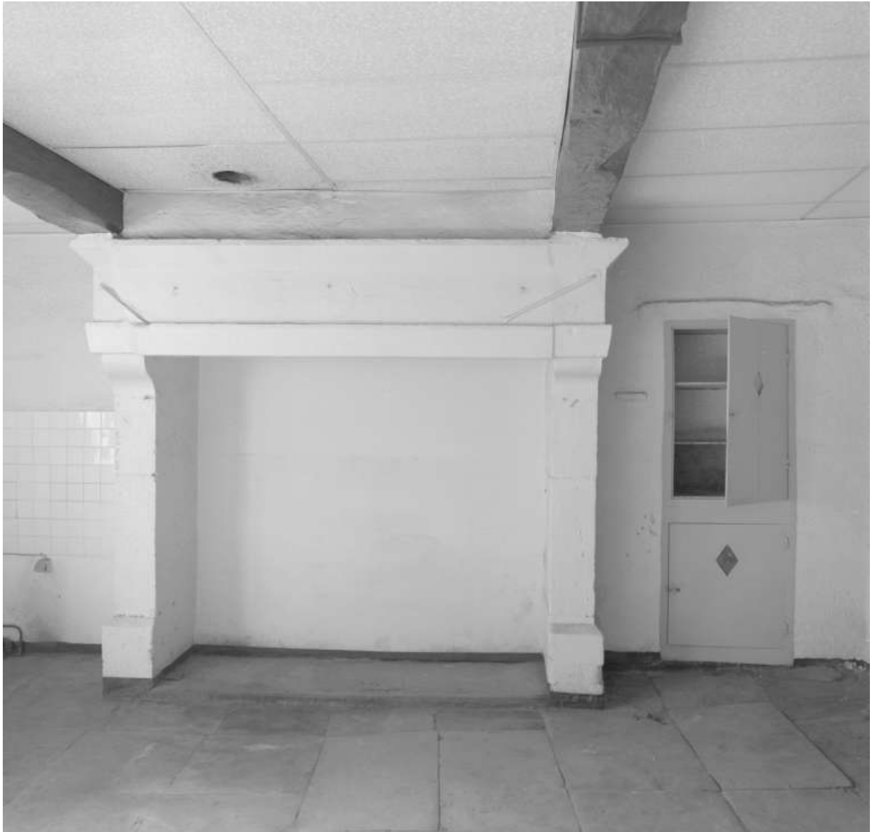
Rue du Coulard, rue de la Poste, maison (AX 100). Ancienne cuisine, au sol dallé en pierre. Il ne reste plus que la cheminée et le potager dans un placard mural.
