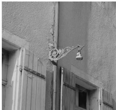
Fig. 7 Détail de la poulie sur la façade principale des ateliers (=tirage disparu).
