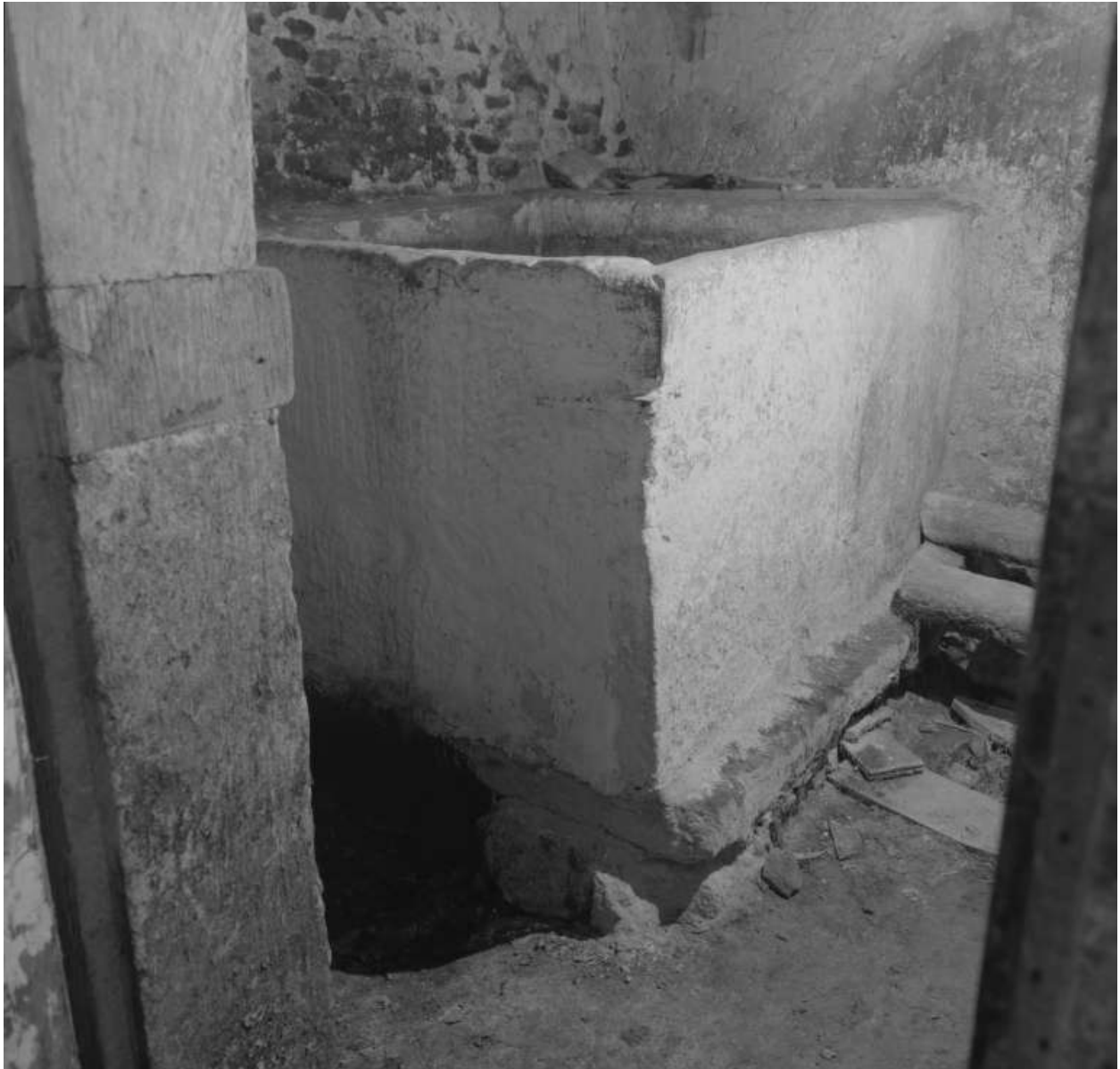
Rue du Coulard, rue de la Poste, maison (AX 100). Cuve à vin située dans une des caves.
