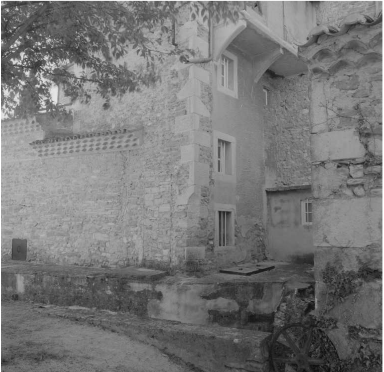
L'Ecluse. Vue partielle du canal et de l'écluse de l'ancien moulinage.
