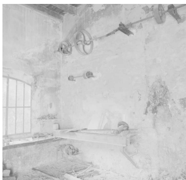
Moulin, essieu d'entraînement des courroies. Phot. Eric Dessert IVR82_20002600739X
