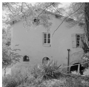
Aile nord, élévation latérale est : mur pignon. Phot. Eric Dessert IVR82_20002600716P
