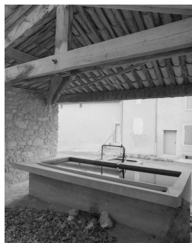
Rousset-les-Vignes. Le lavoir situé près de l'église, récemment restauré. Phot. Alain Franchella IVR82_19982600996X
