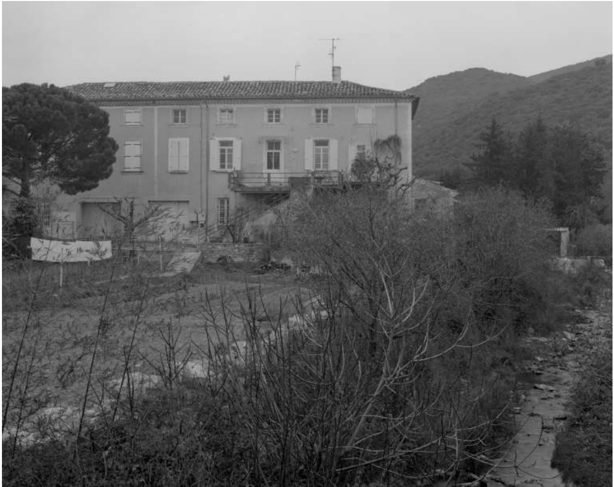
Le Pègue, la Prade (B1 766). Ancien moulinage de soie, implanté près du ruisseau du Donjon.
