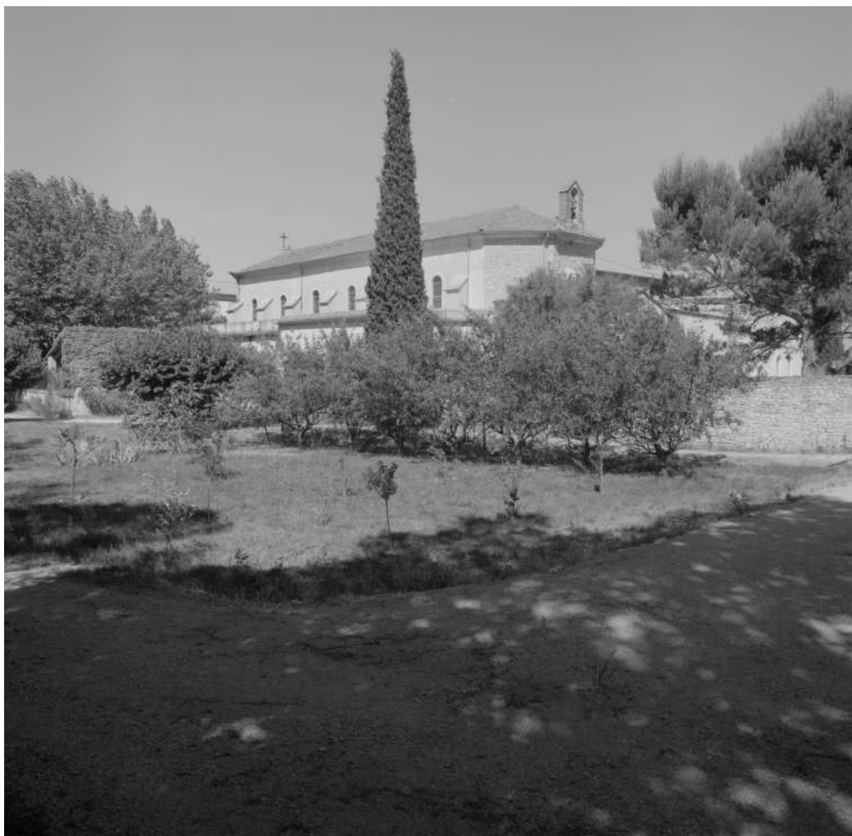
L'Ecluse. La chapelle de l'ancienne usine de l'Ecluse, aujourd'hui du monastère de la Clarté Notre-Dame.
