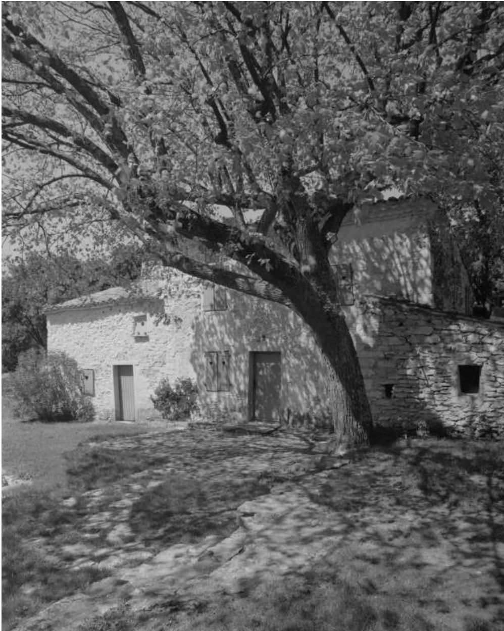
Serre de Pic. Elévation principale : logis et petites dépendances accolées, dont le fournil.
