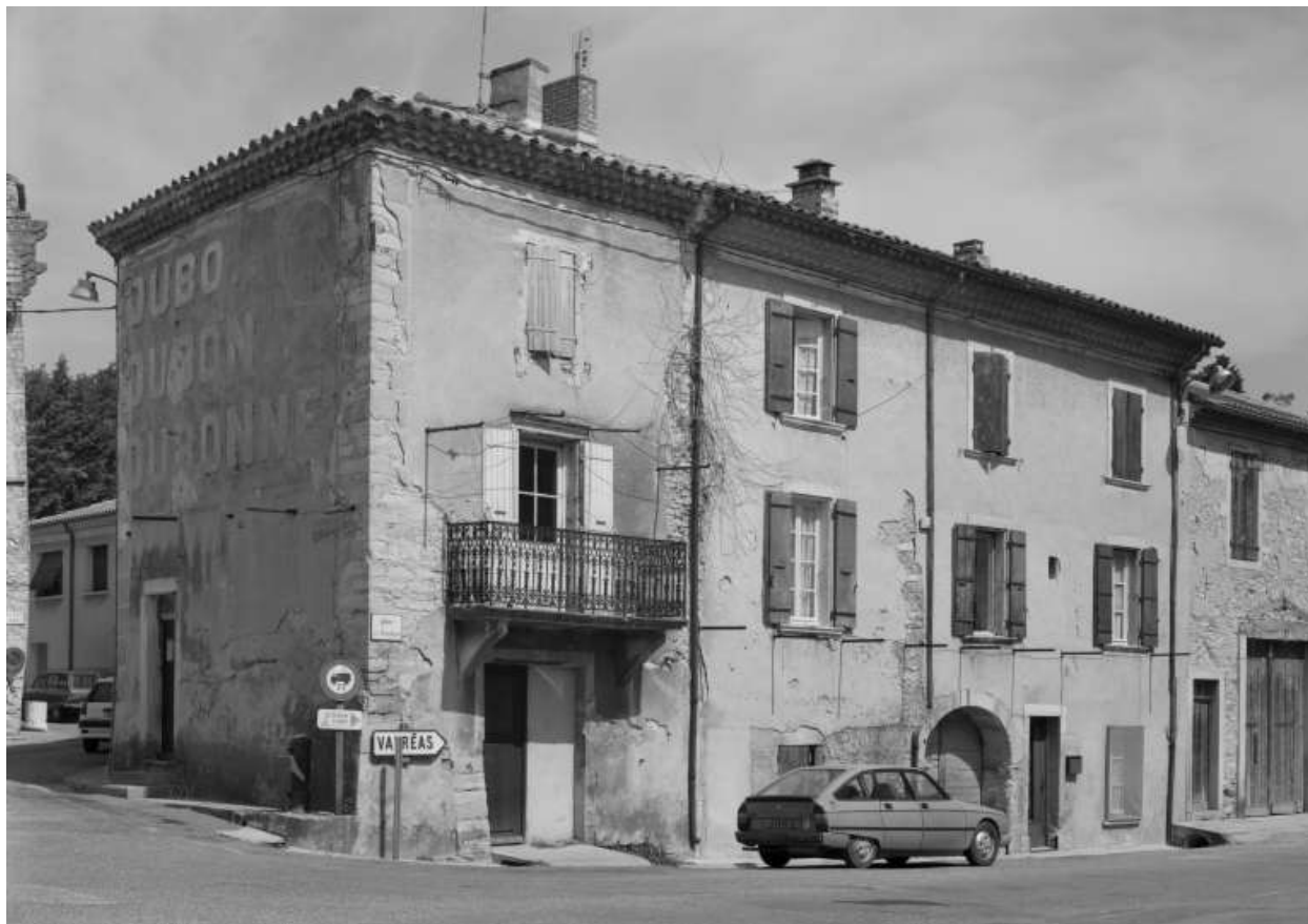
Place de la Résistance. Ensemble d'immeubles construits à l'extérieur des murs, dans le faubourg.
