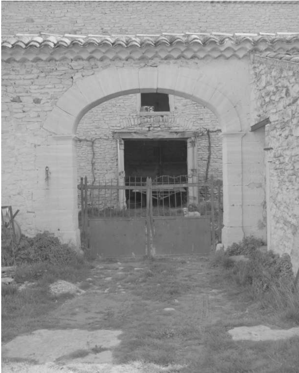
Les Condamines (C1 59). Portail d'entrée sur cour.
