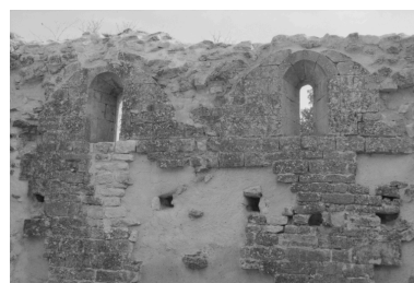
Baies en plein cintre, percées dans le mur sud. Phot. Geneviève Jourdan IVR82_20002600297Z
