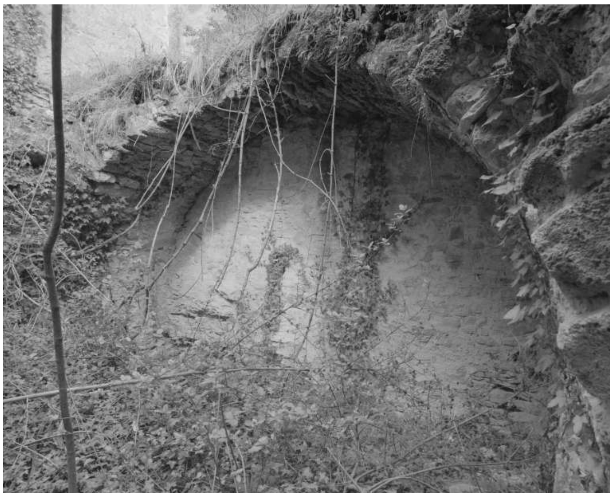
Aiguebelle. Moulin en ruine, vue intérieure : emplacement prévu pour la roue.
