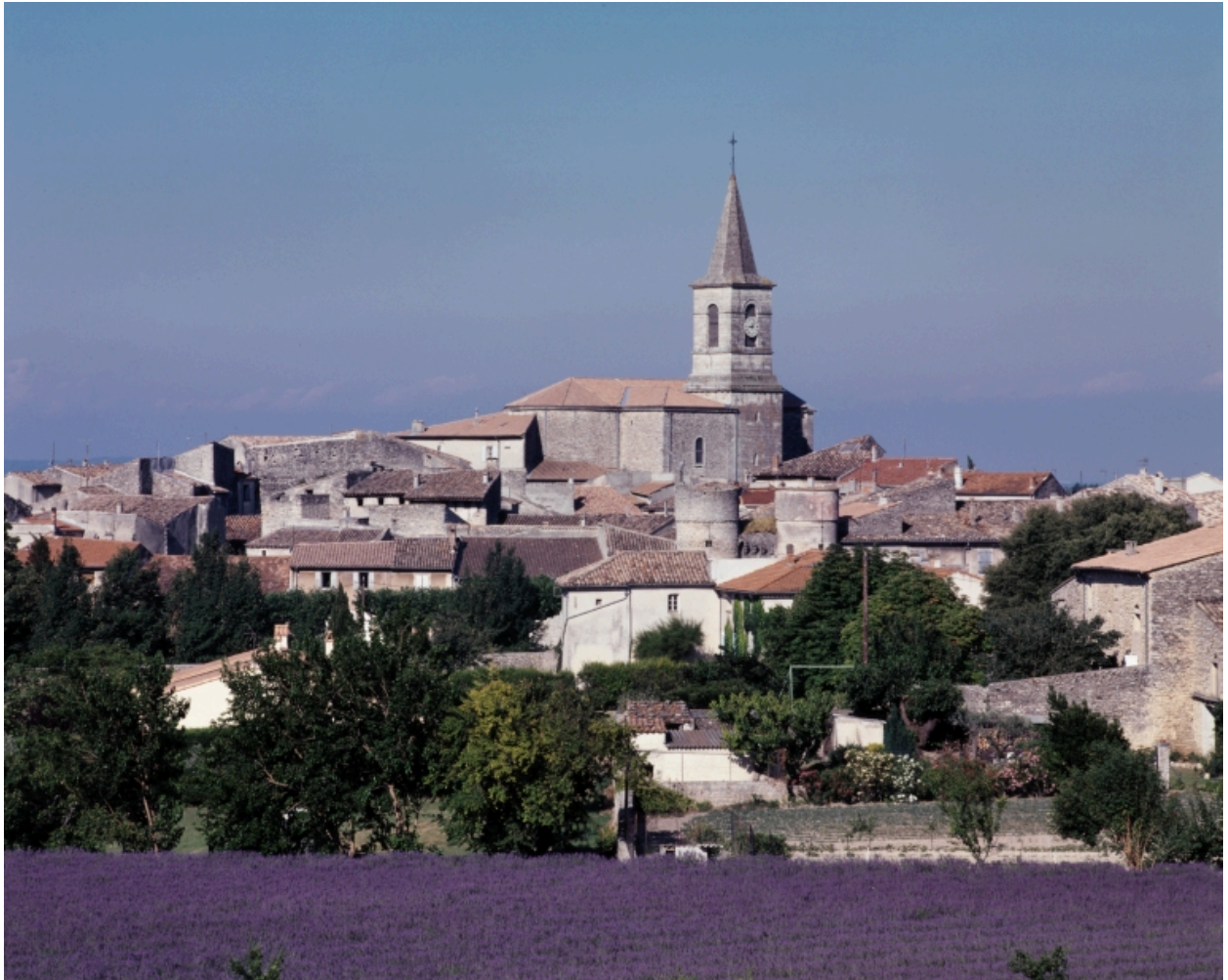
Vue générale dans le site depuis le nord.
