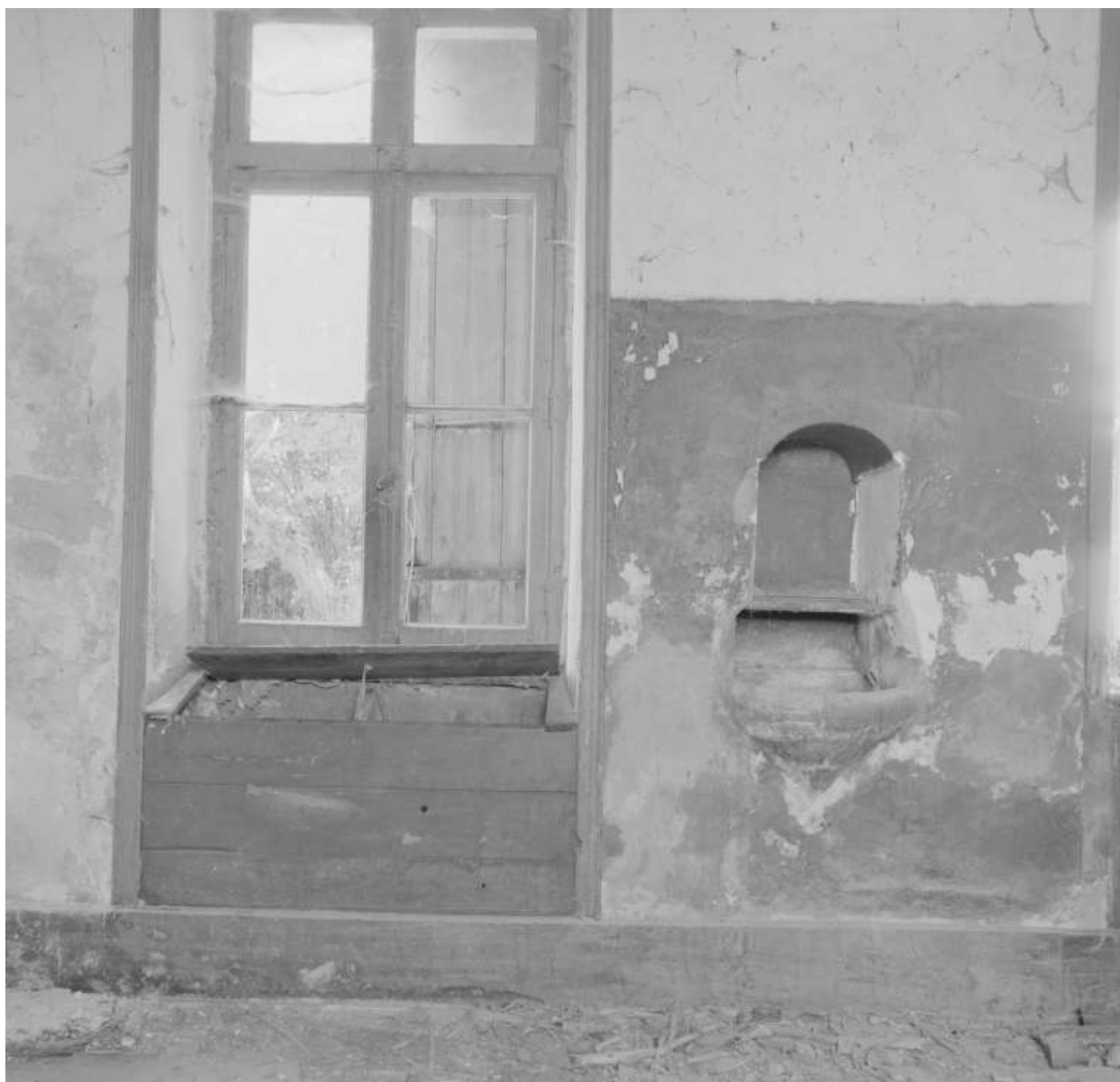
Vue intérieure des ateliers, détail : niche et lavabo.
