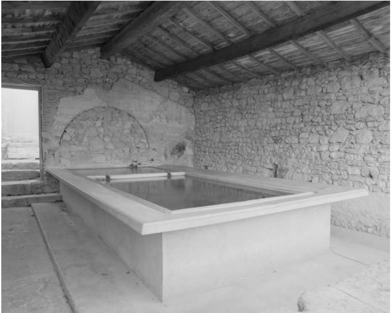
Montjoyer. Village. Vue générale du lavoir.
