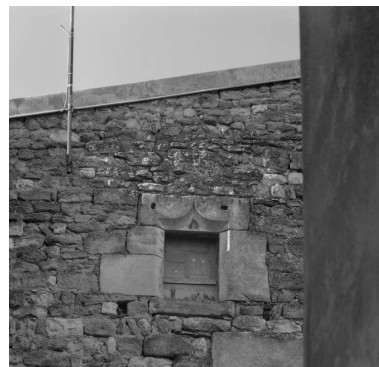
Rue des Fontaines. Détail d'une petite baie chanfreinée au linteau sculpté en accolade.
