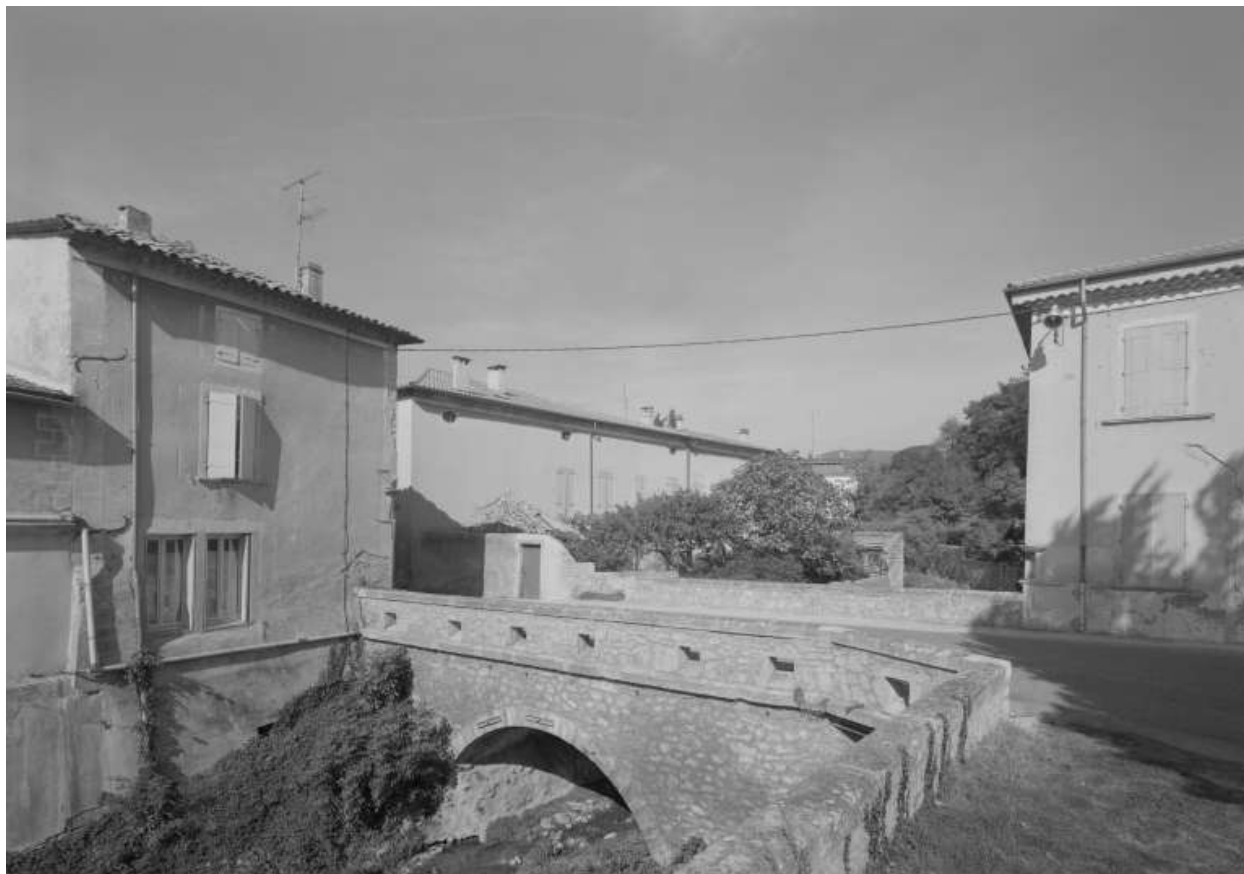
Ancien chemin de Taulignan à Valréas, pont sur la Rialhe reconstruit en 1913 sur des substructions plus anciennes.
