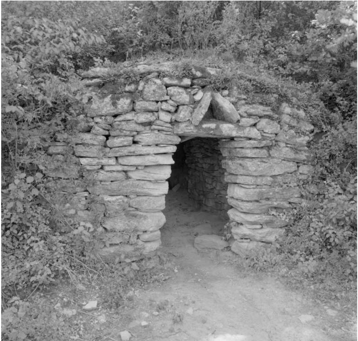
Chamaret. Les Evabres. Vue générale de la cabane (borie n° 5).
