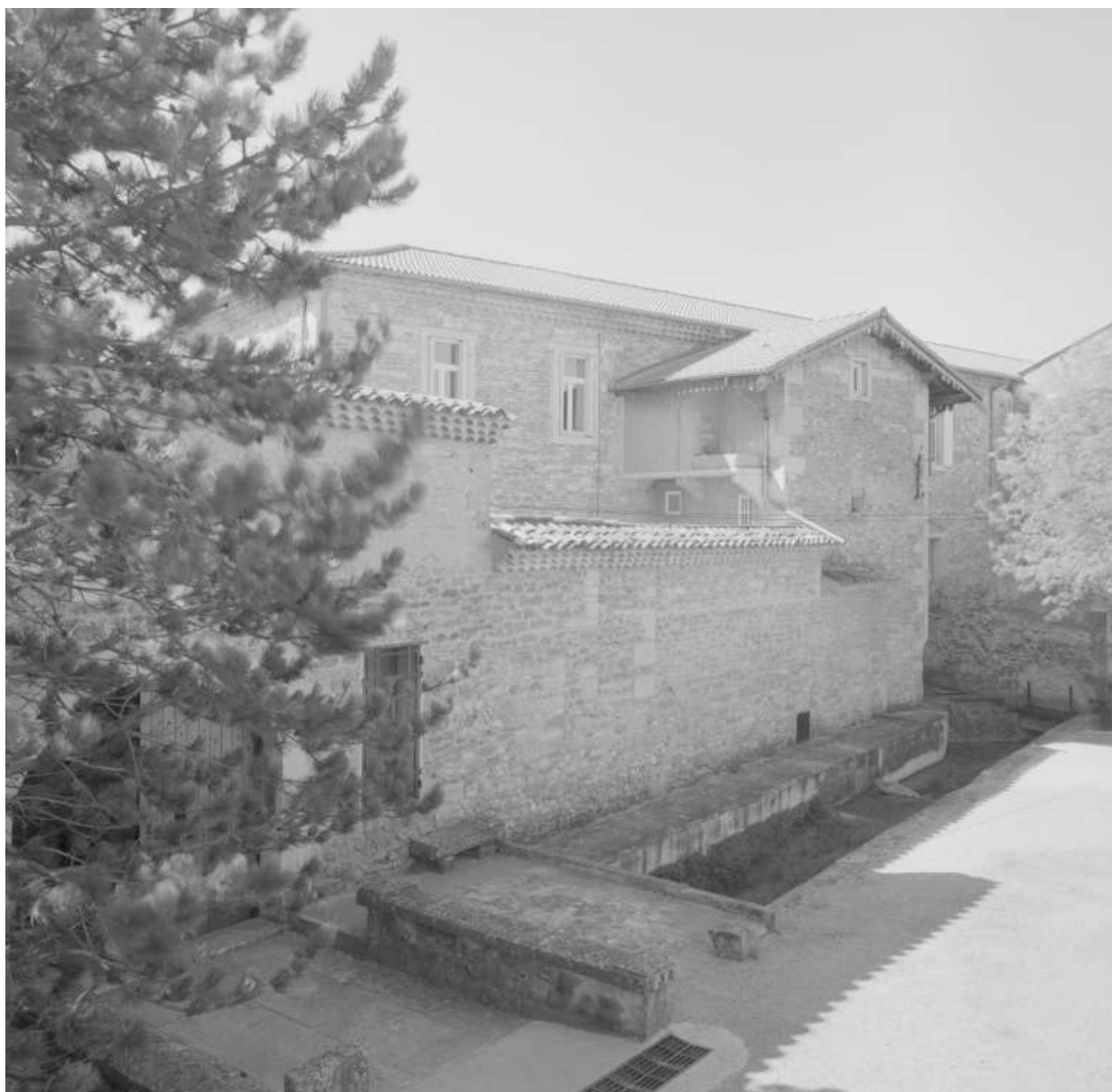
L'Ecluse. Vue partielle du canal et de l'entrée de l'ancien moulinage.
