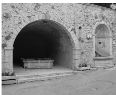
Taulignan. Rue des Fontaines. Vue d'ensemble du lavoir sous voûte et la fontaine associée. Phot. Alain Franchella IVR82_20002600421X
