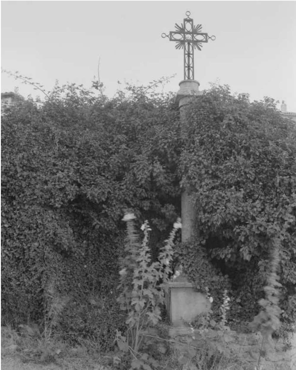
Rousset-les-Vignes, village, le Clos. Croix dite de la placette, avant restauration (croisillon en fer).
