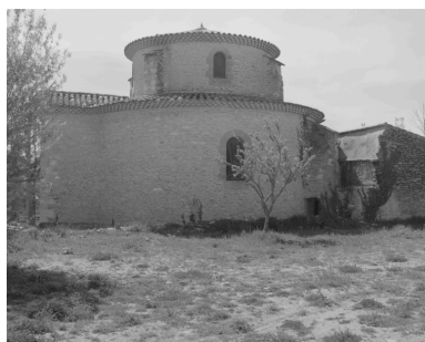
Vue d'ensemble depuis l'est. Phot. Alain Franchella IVR82_20002600423X
