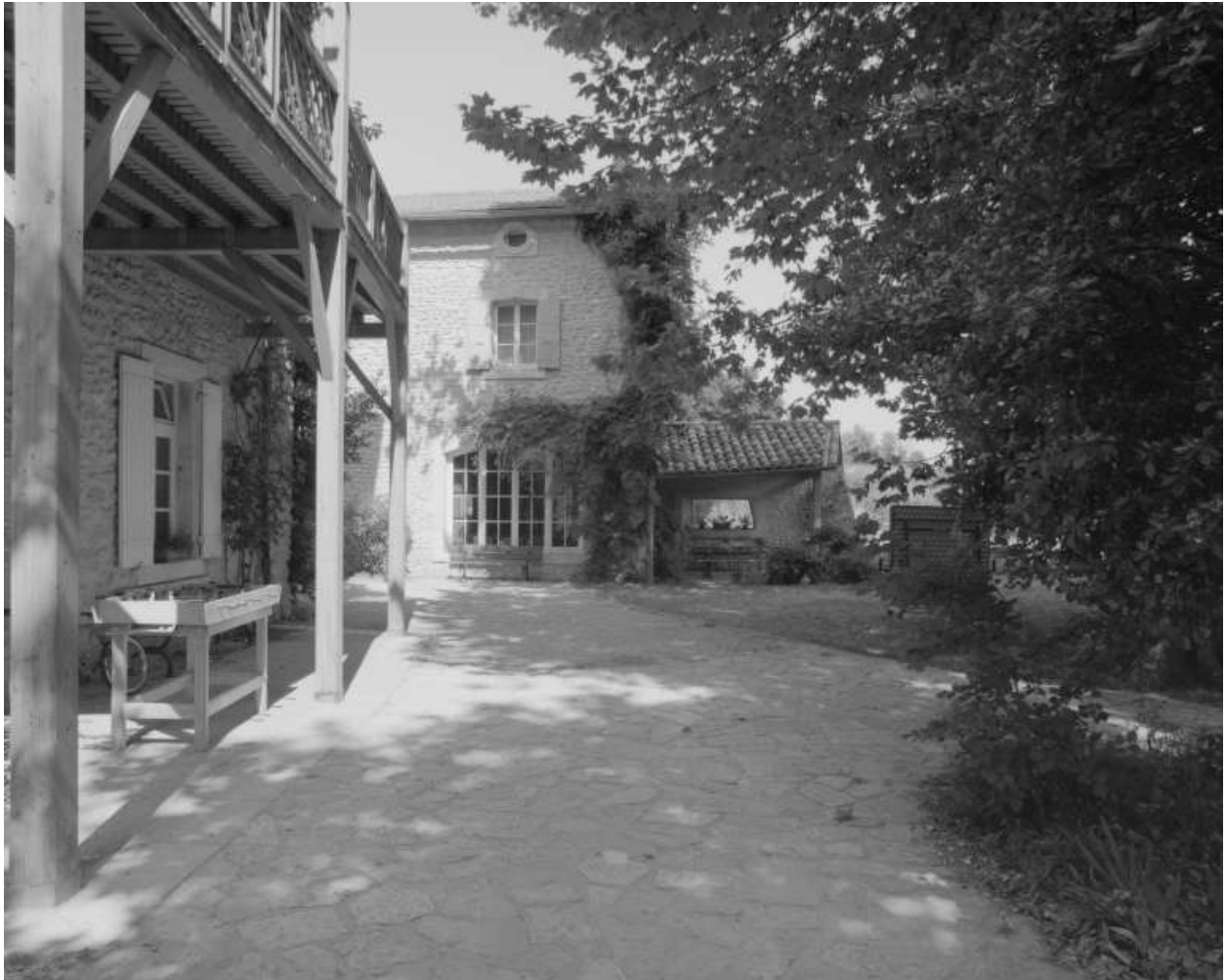
Le Béal. Moulinage. Vue partielle de l'orangerie.
