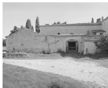
Les Condamines (C1 59). Vue d'ensemble de la ferme. Phot. Alain Franchella IVR82_20002600374X
