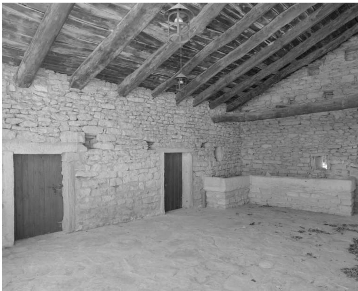
La Garrigue. Intérieur du hangar.
