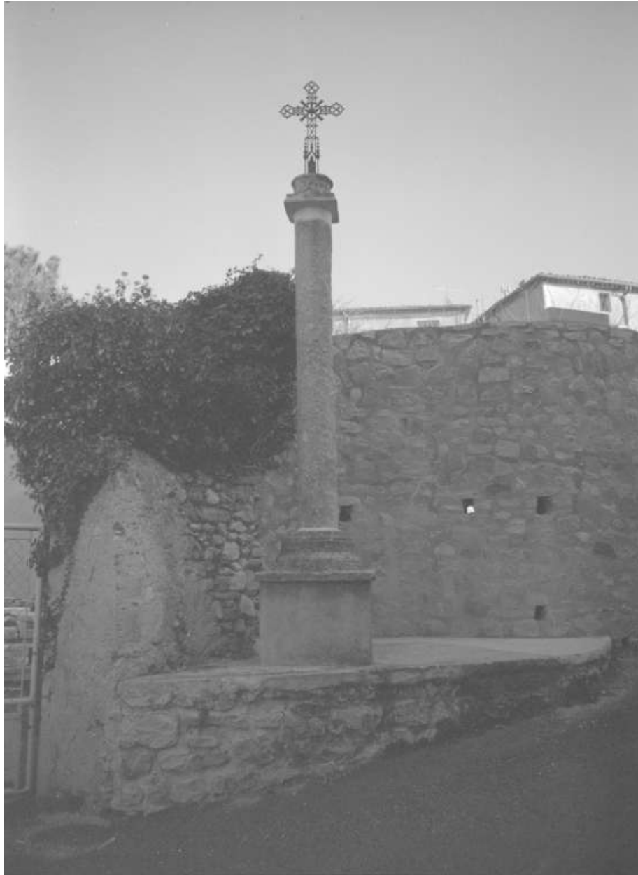
Rousset-les-Vignes, village, le Clos. La croix, dite de la placette, restaurée en 2004 (?), dont le croisillon en fer a été remplacé par un en fonte.
