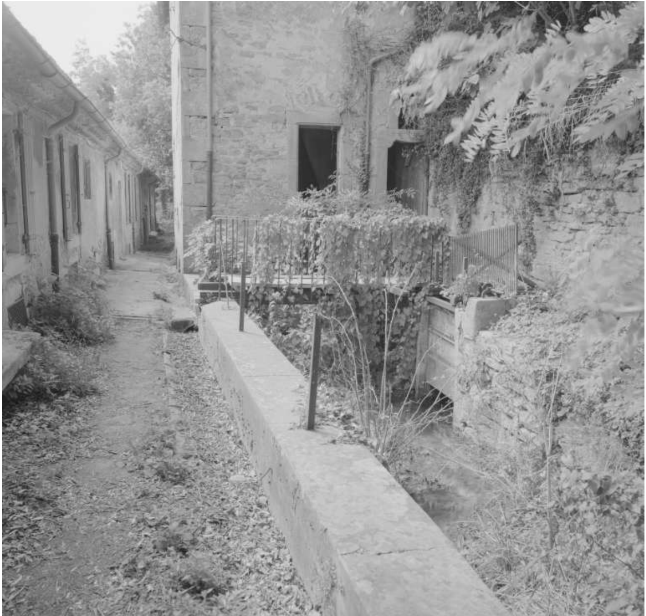
Vue partielle du canal et de l'écluse ; la passerelle au-dessus du canal donne accès au moulin.
