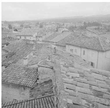
Vue des toits des maisons situées dans le quartier nord, rue des Fontaines. Phot. Eric Dessert IVR82_20012600119X
