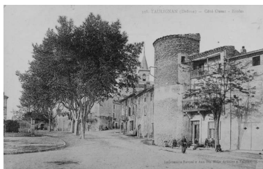
Taulignan. Côté ouest. Ecoles. Phot. Eric (reproduction) Dessert, Autr. Revoul (imprimeur) IVR82_20012600099X
