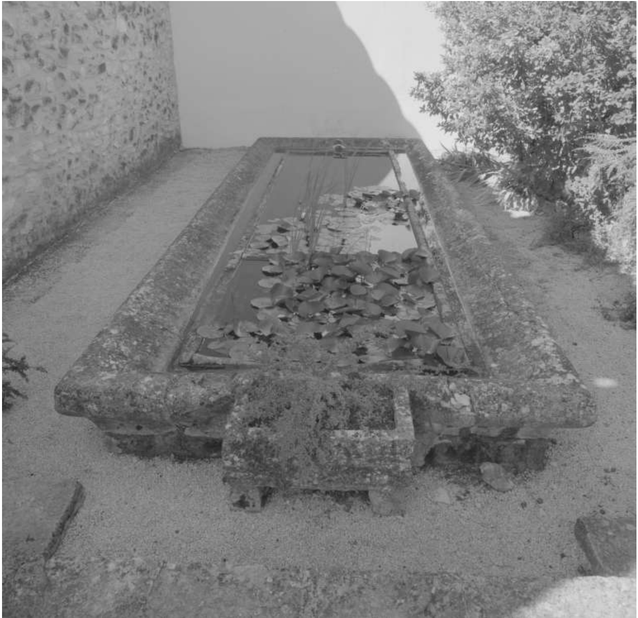
L'Ecluse. Bassin-lavoir de l'ancienne usine.
