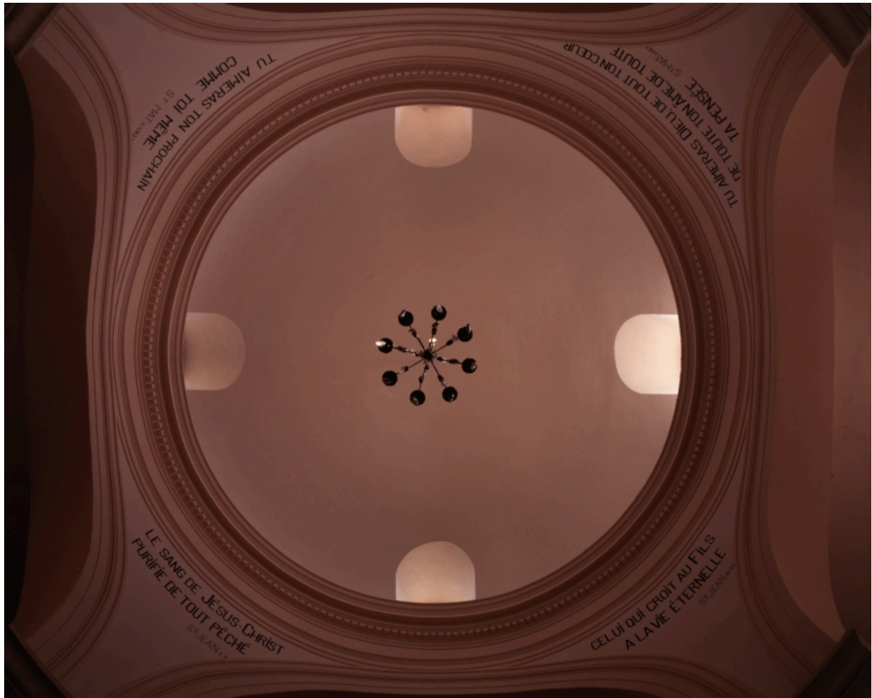
Coupole, vue d'ensemble.
