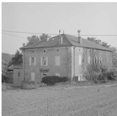
Voie communale n°2 de Grillon à Taulignan. Vue de trois quarts de l'ancienne fabrique, dite "usine brûlée", qui dépendait de l'usine Faujas. Phot. Eric Dessert IVR82_20002600748X
