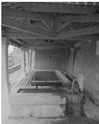
Le lavoir de Valaurie, vue de l'intérieur. Phot. Alain Franchella IVR82_19972600551X
