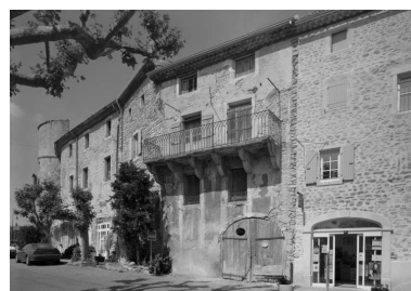
Place du 11 Novembre : ensemble de maisons adossées aux murailles de fortification et l'une des onze tours. Phot. Eric Dessert IVR82_20002601136P
