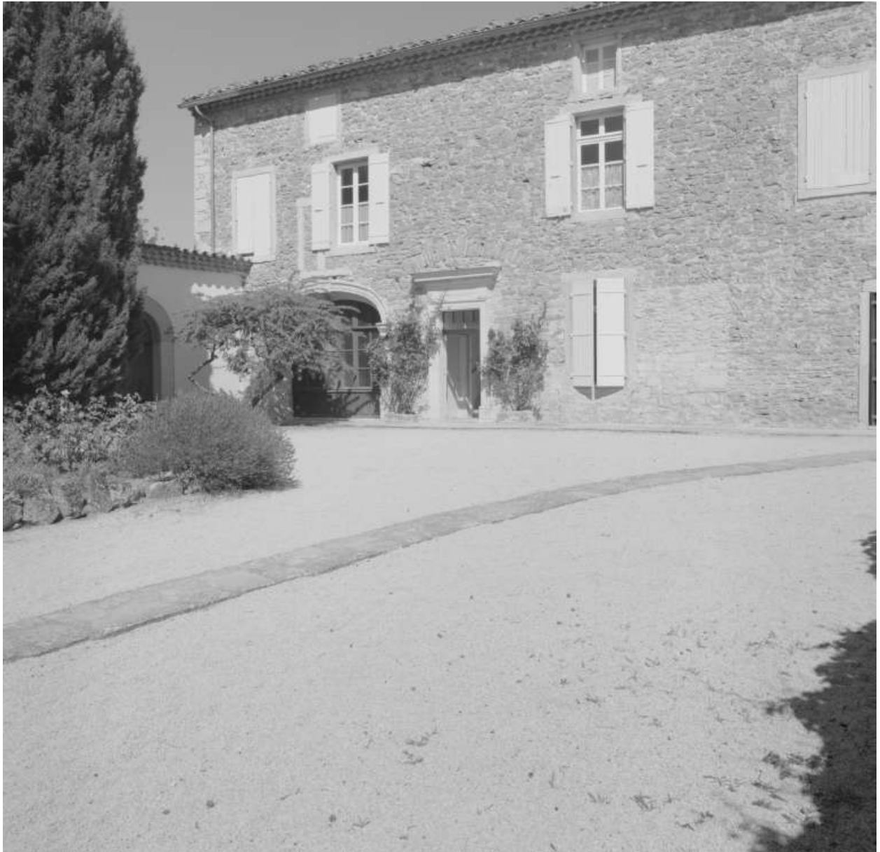
L'Ecluse. Vue partielle du moulinage.
