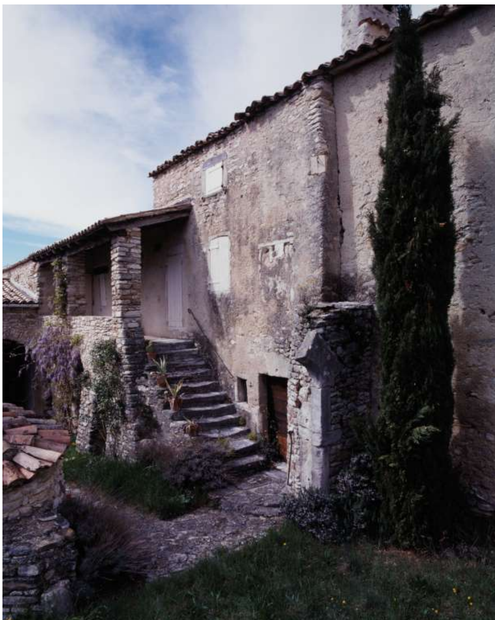
Chèvre, chemin vicinal de Taulignan au Poët-Laval. Élévation principale : escalier extérieur et galerie desservant le logis à l'étage.
