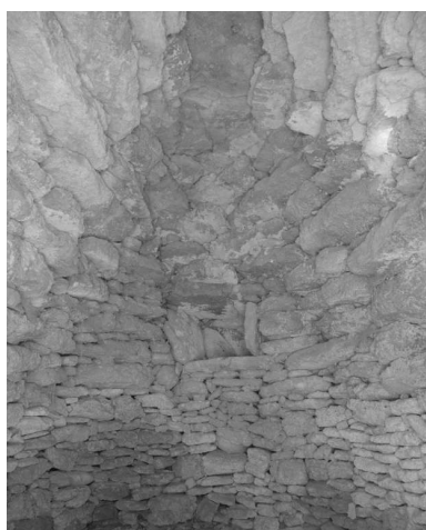
Taulignan, Esclouseau. Couvrement intérieur de la borie : principe de la coupole en encorbellement. Phot. Alain Franchella IVR82_20002600458X
