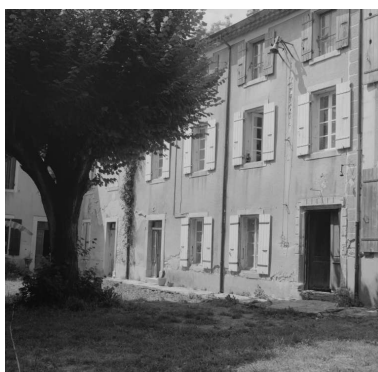
Vue partielle de l'élévation principale des ateliers de moulinage. Phot. Eric Dessert IVR82_20002600731X
