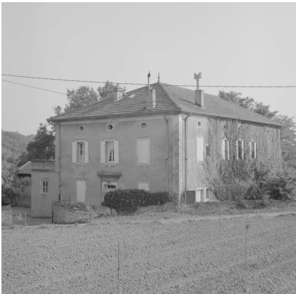
Voie communale n°2 de Grillon à Taulignan. Vue de trois quarts de l'ancienne fabrique, dite "usine brûlée", qui dépendait de l'usine Faujas.
