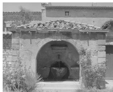
Grignan. Hameau de Bayonne. Vue de la fontaine publique. Phot. Alain Franchella IVR82_20002600648X
