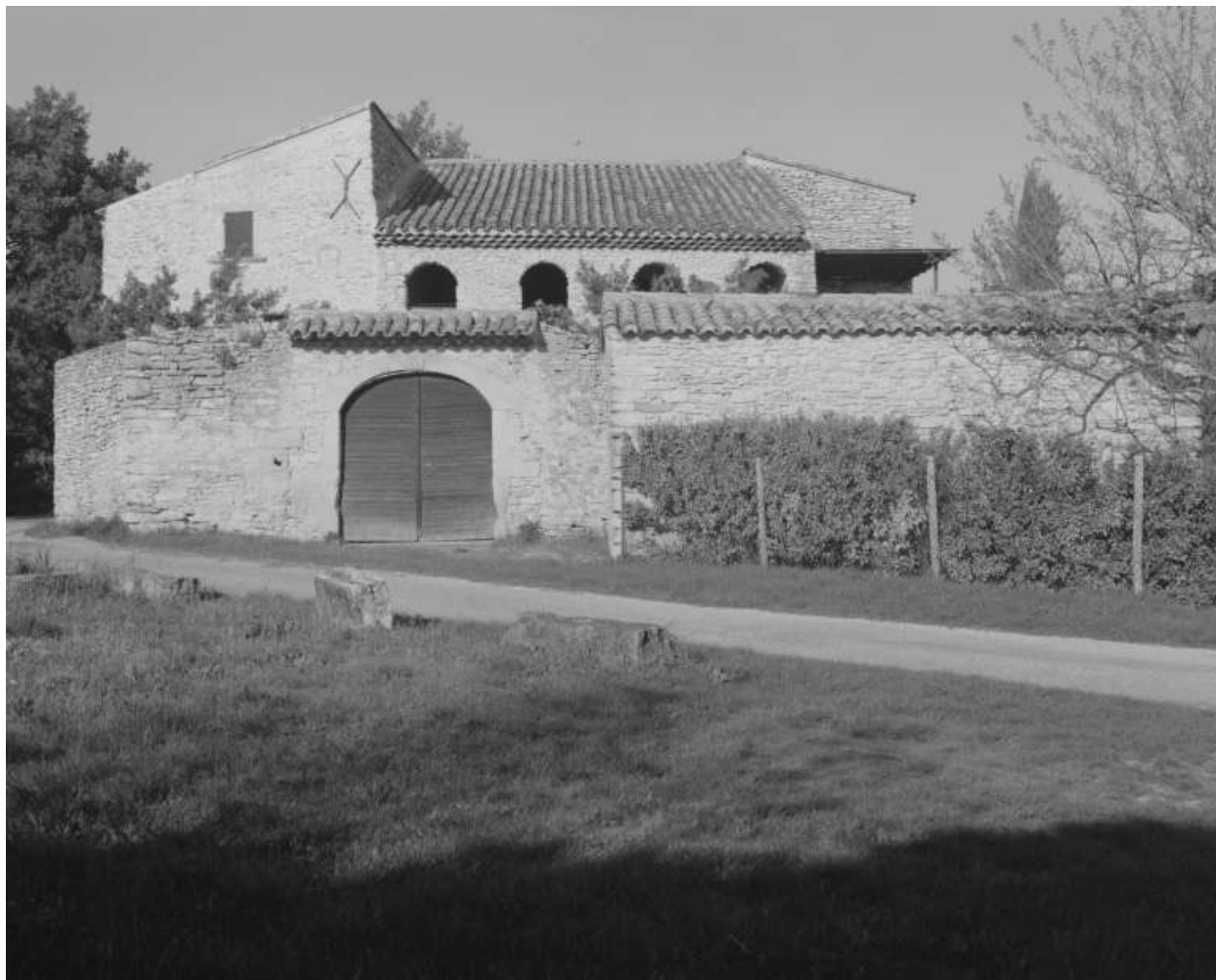
Serret, chemin de l'Alençonne. Vue d'ensemble de l'Alençonne, ancienne ferme et à l'origine léproserie.
