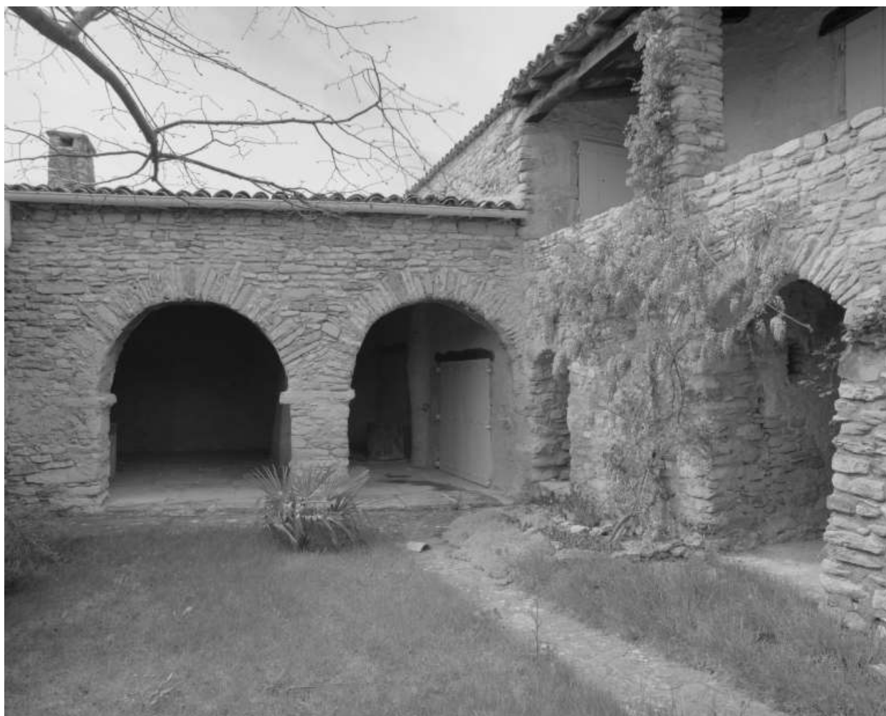
Chèvre, chemin de Taulignan au Poët-Laval. Vue de la galerie depuis la cour, et d'une ancienne dépendance.
