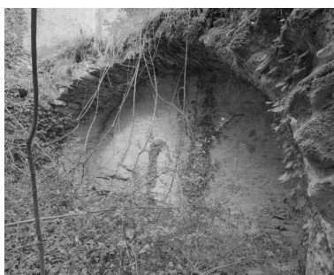
Aiguebelle. Moulin en ruine, vue intérieure : emplacement prévu pour la roue. Phot. Alain Franchella IVR82_20002600384X
