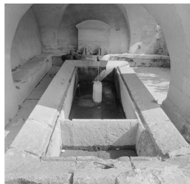
Chamaret. Le Colombier. Vue intérieure du lavoir dit la grande fontaine. Phot. Alain Franchella IVR82_19992600242X
