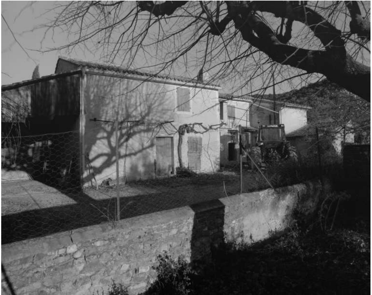
Montbrison, route de Crest (R.D. 538). Vue d'ensemble de la ferme depuis le verger.
