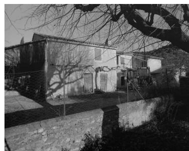
Montbrison, route de Crest (R.D. 538). Vue d'ensemble de la ferme depuis le verger. Phot. Alain Franchella IVR82_19982601009X
